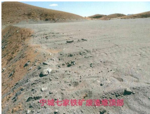
照片 2-5 排渣场堆顶部整平
