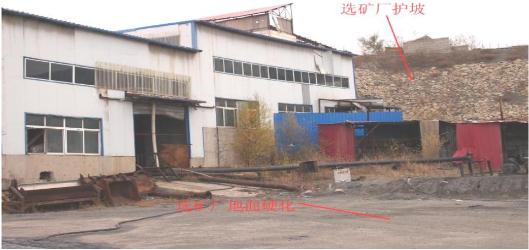
照片 2-2 选矿厂的地面硬化及修建的护坡
