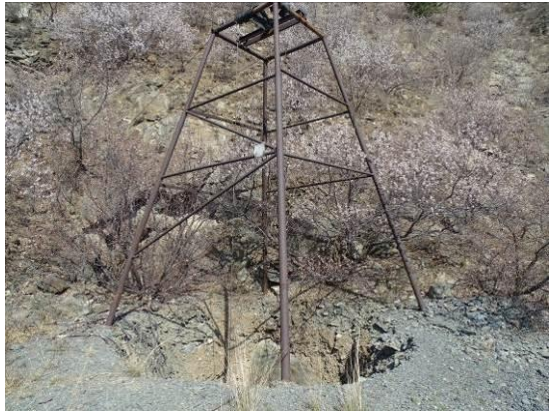
照片 3-8 工业场地 2 内竖井 1
