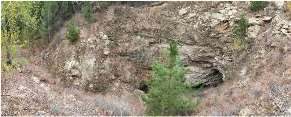
照片 3-50 民采平硐及场地切坡
