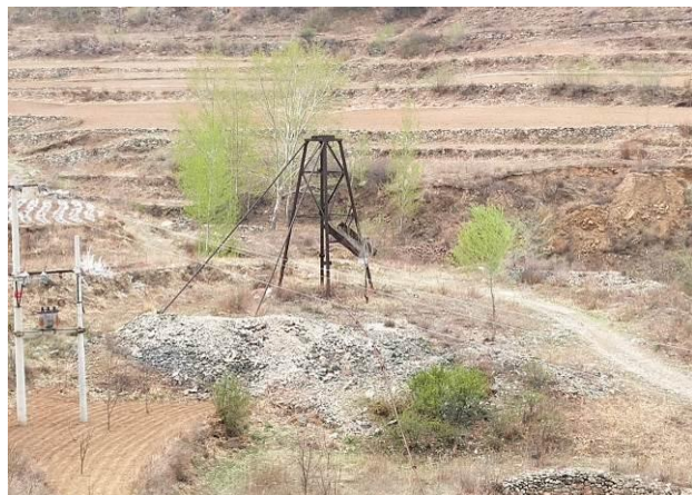
照片 3-40 工业场地 4 内竖井 4 及废渣 9
