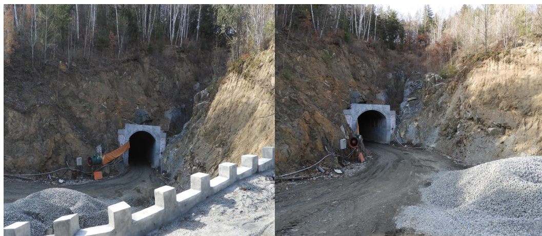
照片 3-1 斜坡道口及切坡
