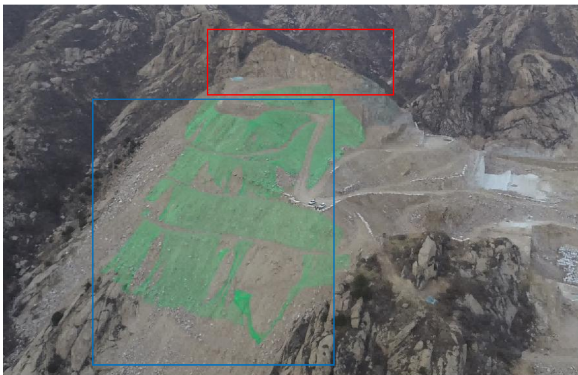
照片 2-5 露天采场 1 垫坡整形效果（红色框）、渣坡整形效果（蓝色框）
