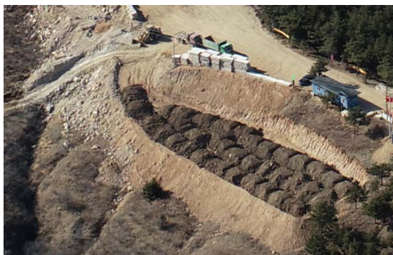
照片 4-7 表土存放场
