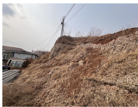
照片 3-2 办公生活区北西侧边坡治理效果 (西南侧)
