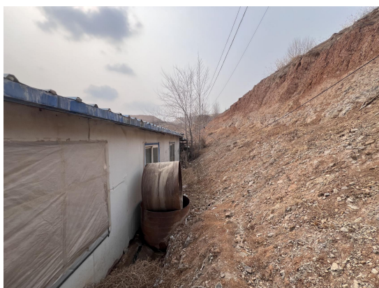
照片 3-1 办公生活区北西侧边坡治理效果 (东北侧)
