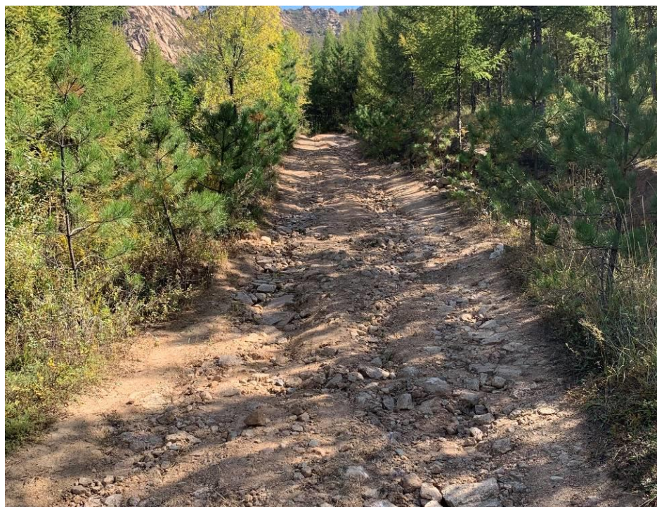
照片 4-6 矿区道路
