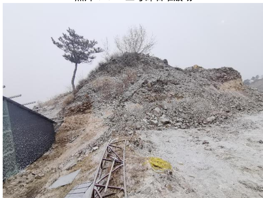
照片 4-5 二号碎石堆放场西侧
