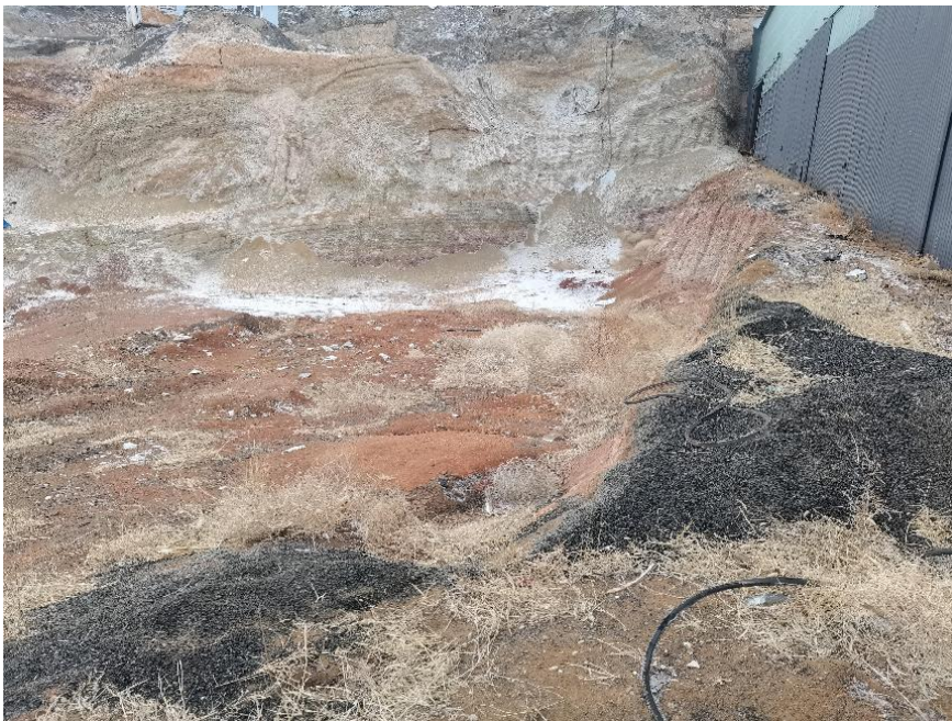
照片 4-3 工业场地东侧边坡
