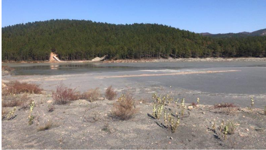
照片 4-19 尾矿库库面
