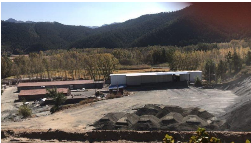
照片 4-20 尾矿库工人宿舍、车间和料堆
