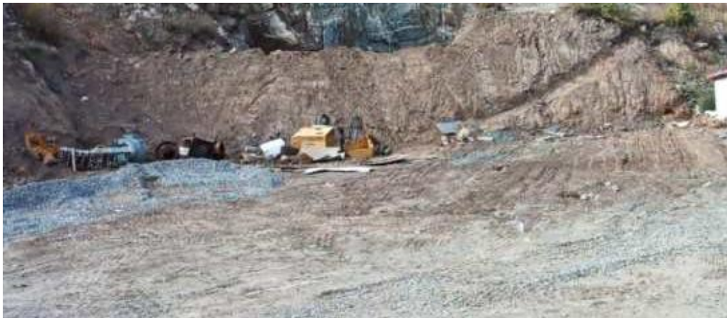
照片2-1 废石堆治理效果（现状竖井工业场地西部）
