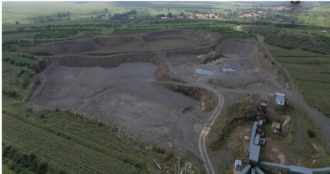
照片 4-1 露天采场现状
