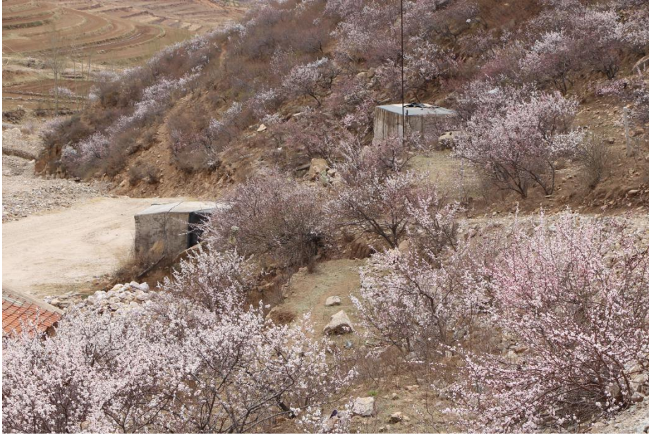
照片 4-7 炸药库、雷管库
