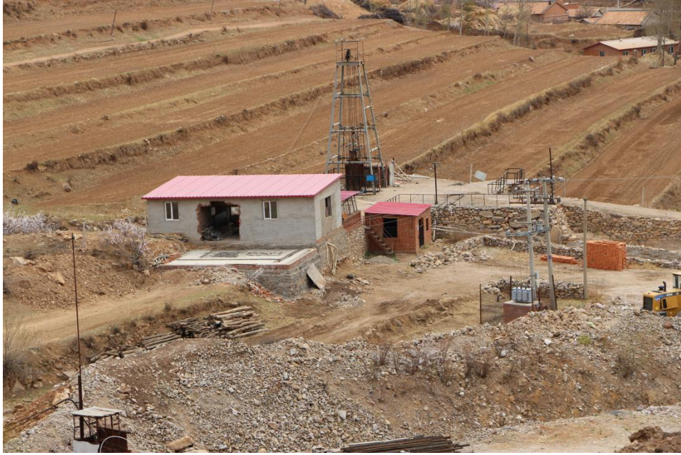
照片 4-2 竖井工业场地
