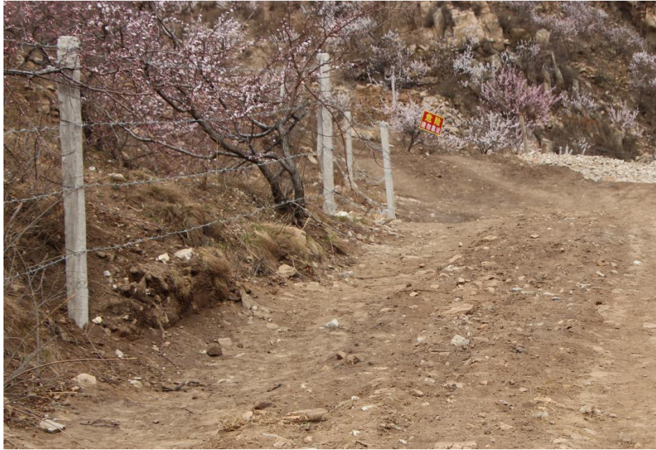
照片 2-1 现状治理区照片
