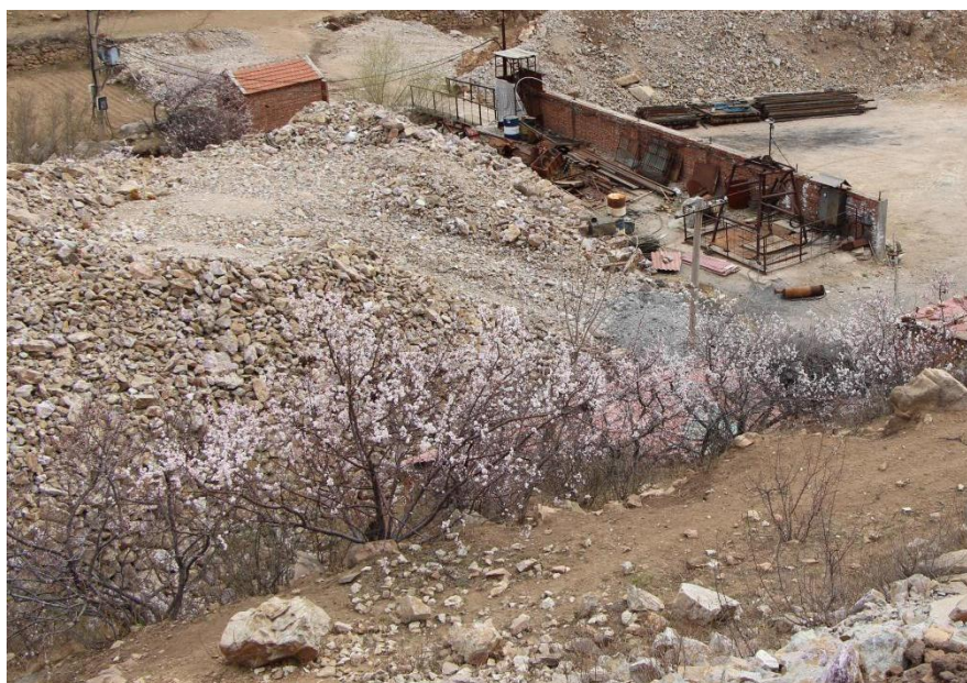
照片 4-4 风井工业场地
