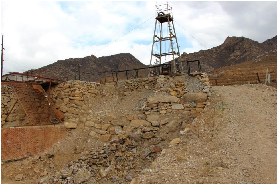
照片 4-3 竖井工业场地
