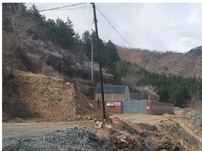
照片 4-7 炸药库（雷管库）
