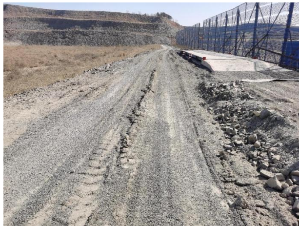
照片 4-5 矿区道路
