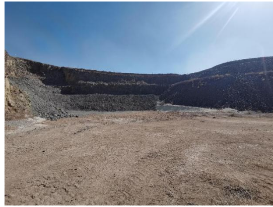
照片2-4 1#露天采场东侧部分区域治理效果
