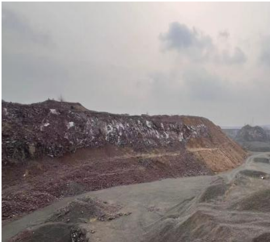
照片3-1 露天采场南部南部边坡治理效果图（南段）
