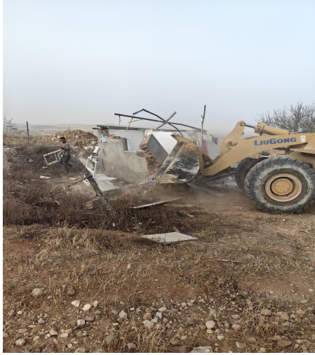
值班室 恢复照片
