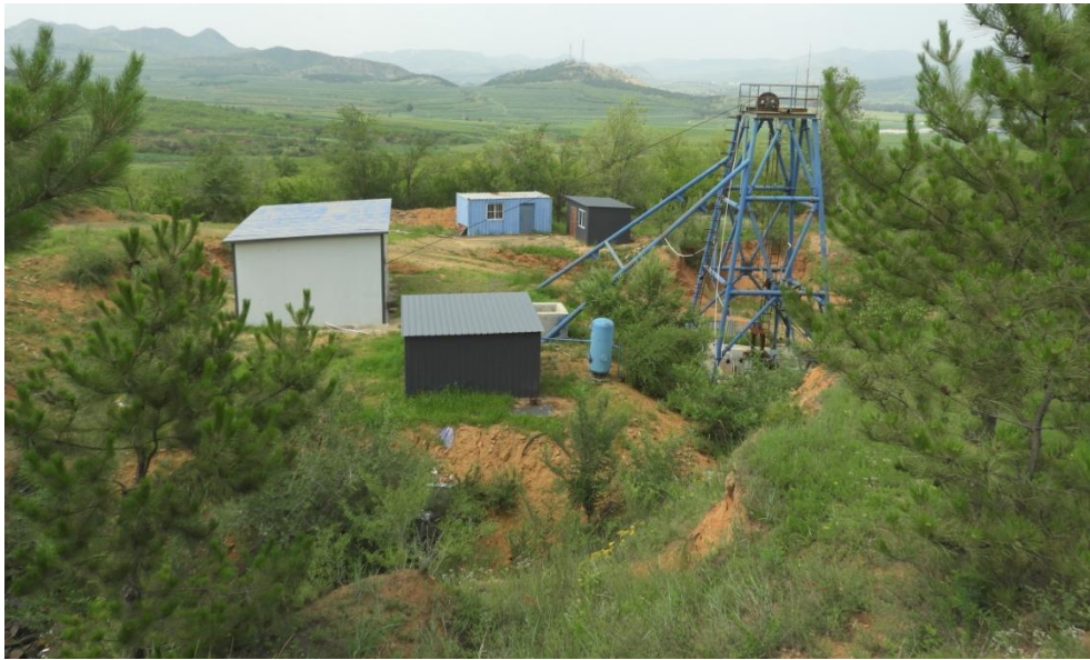
照片 4-4 竖井（SJ4）工业场地
