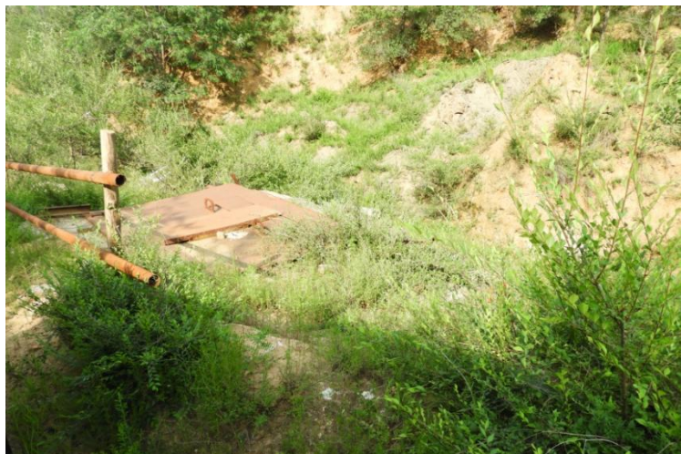
照片 4-1 竖井（SJ1）工业场地
