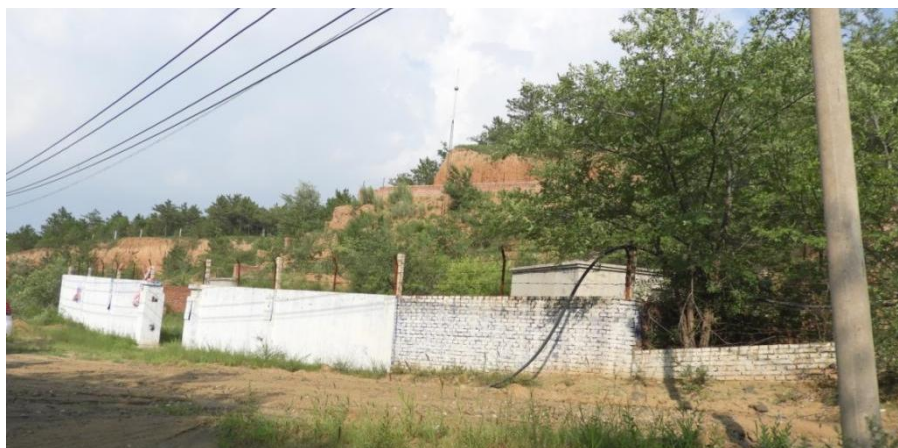
照片 4-27 炸药库近景
