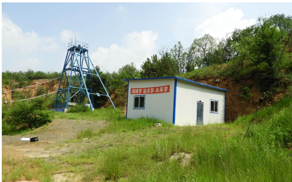
照片 4-3 竖井（SJ3）工业场地
