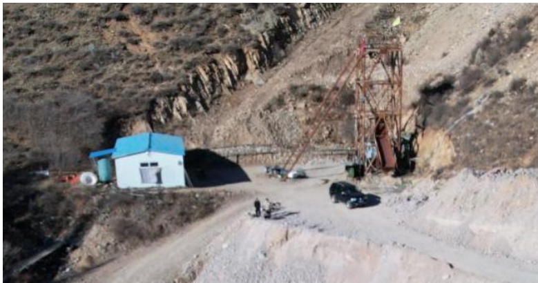
照片 4-12 竖井工业场地
