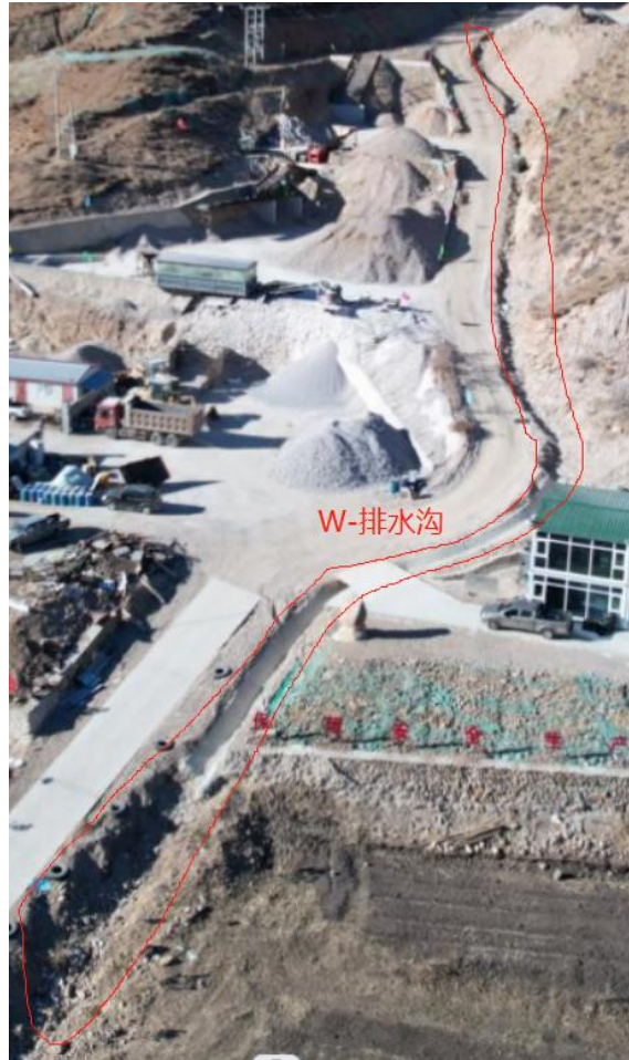
照片 4-26 W-排水沟
