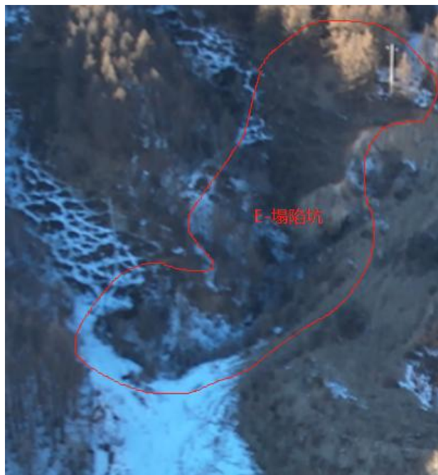
照片 4-9 E-民采塌陷坑
