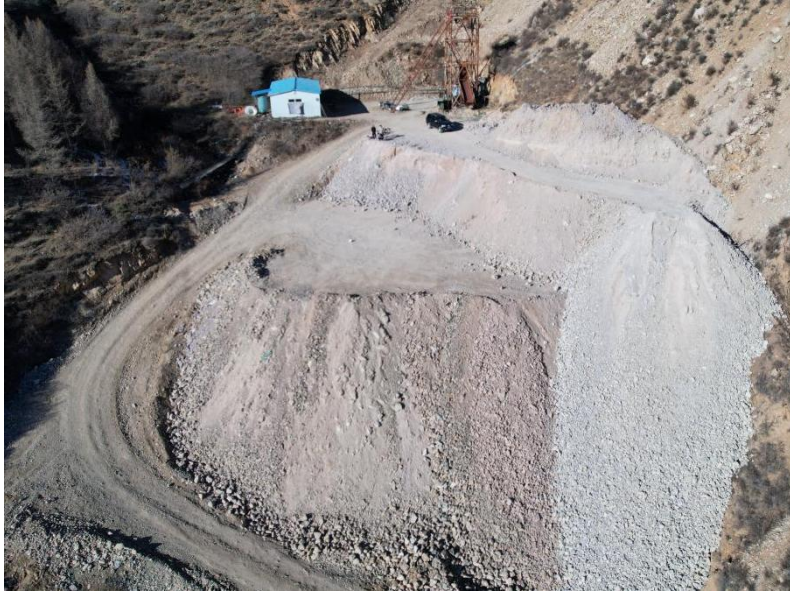
照片 4-13 竖井废石场
