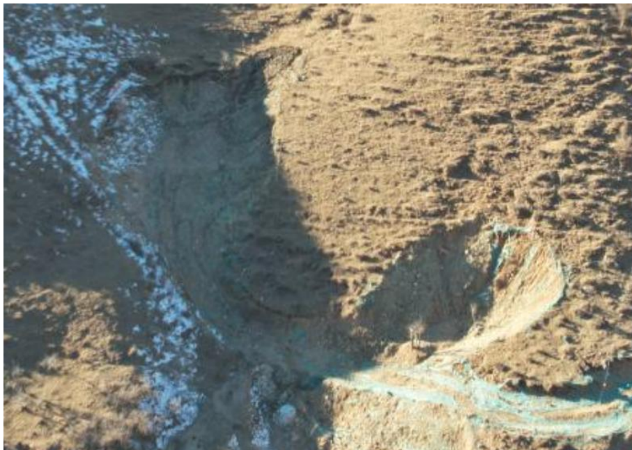
图 2-7 民采坑 1、民采坑 2 治理效果照片
