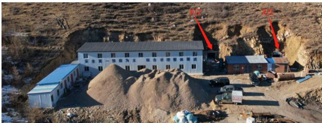
照片 4-1 斜井工业场地
