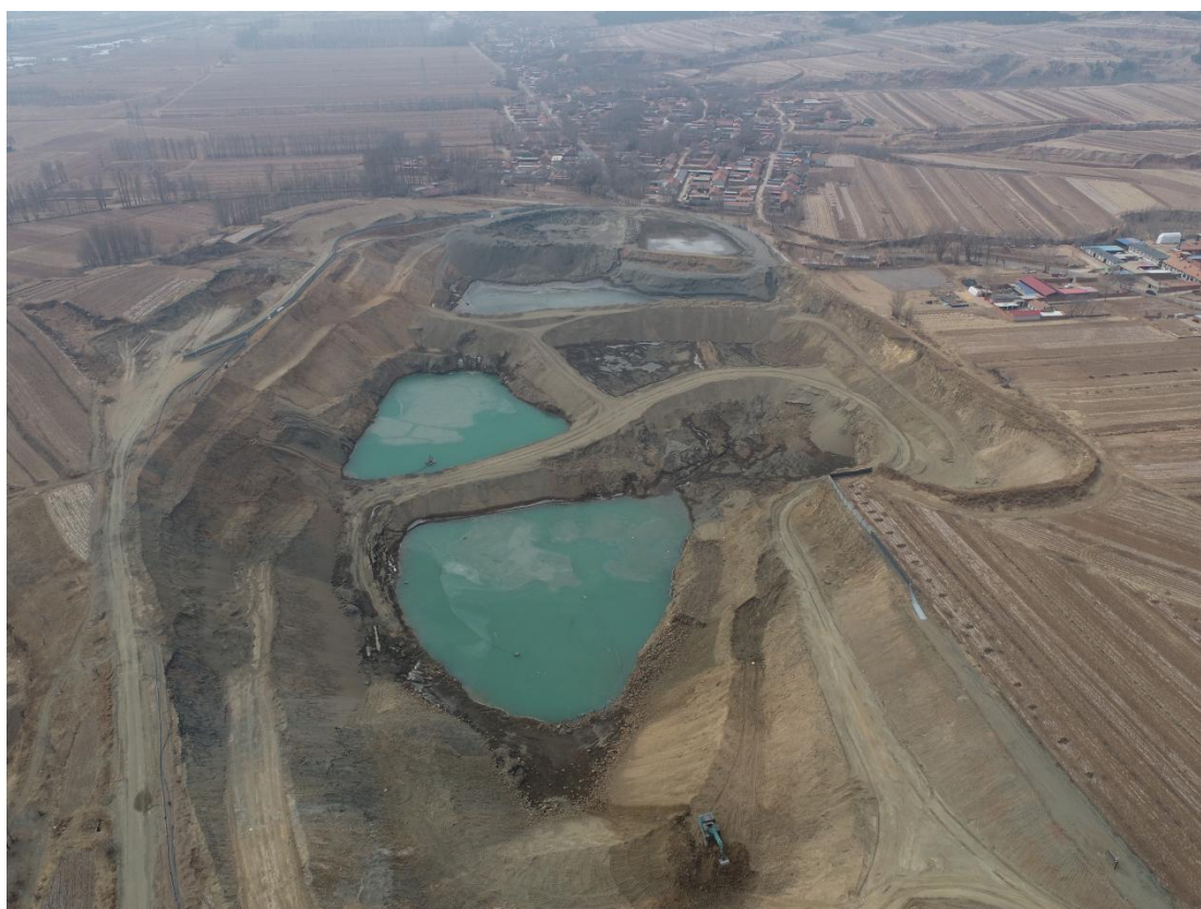
照片 4-1 露天采场 1 全景
