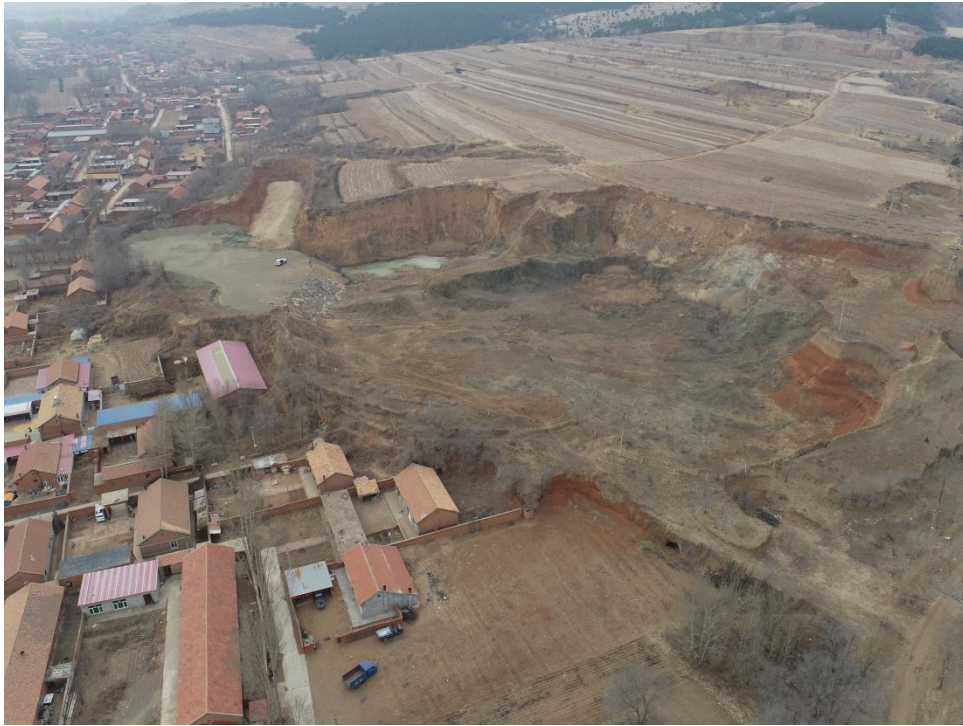
照片 4-2 露天采场 2 全景
