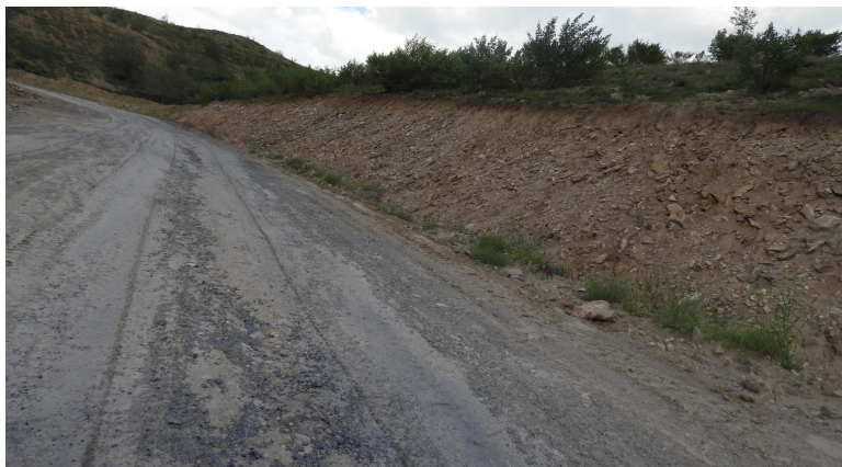
照片 3-8 矿区道路
