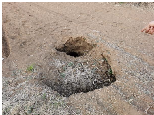
照片 4-1 地面塌陷坑
