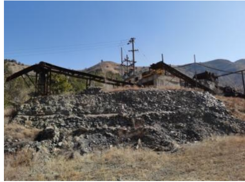
B 南侧挡墙
