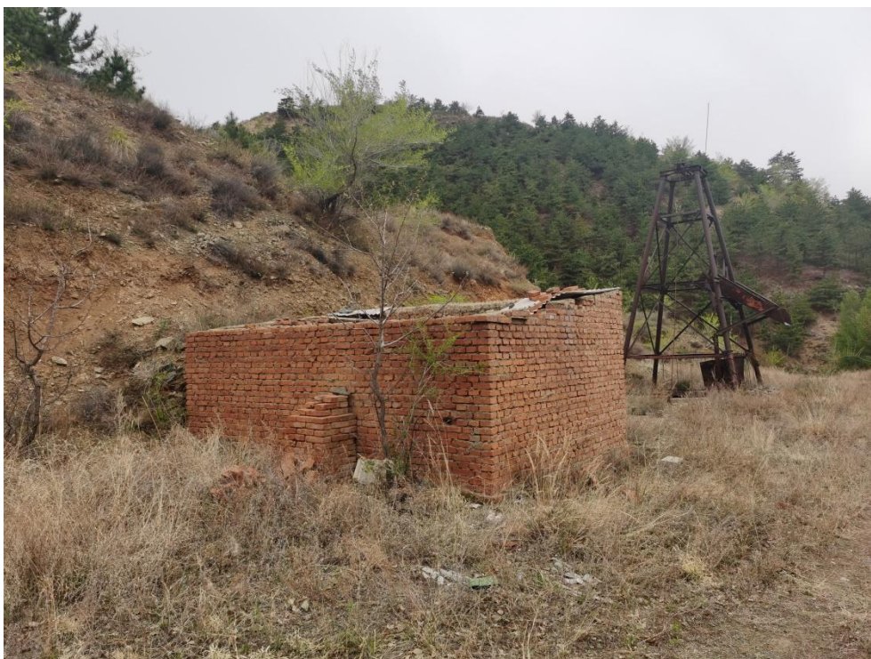
照片 4-10 民采竖井 M 民采竖井 SJ4 工业场地
