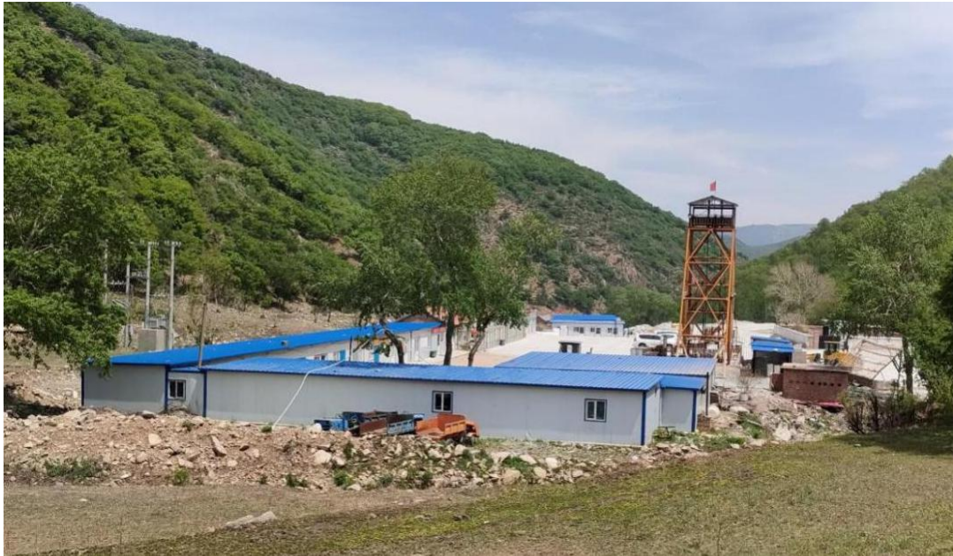
照片 4-1 竖井工业场地
