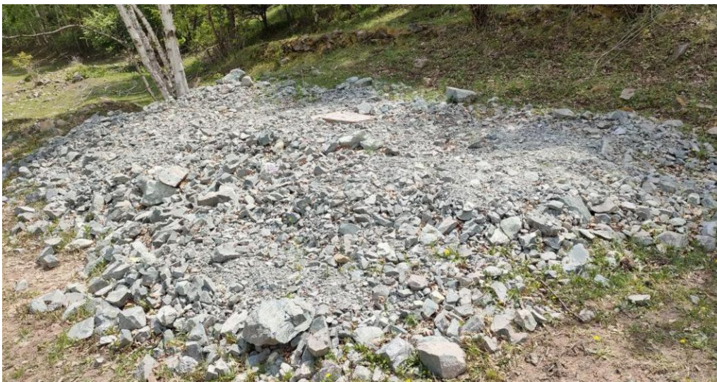
照片 4-7 钻机平台
