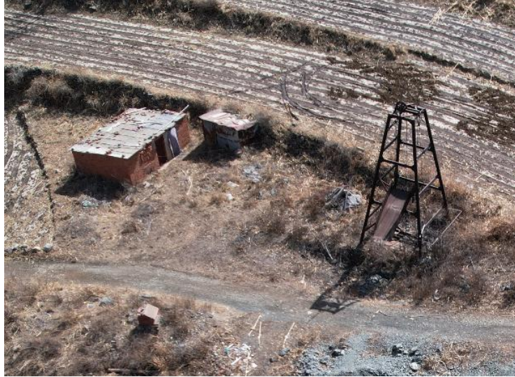
照片 4-1 废弃竖井工业场地
