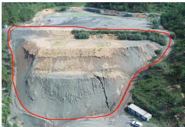
照片2-4 尾矿库坝基坡面治理效果
