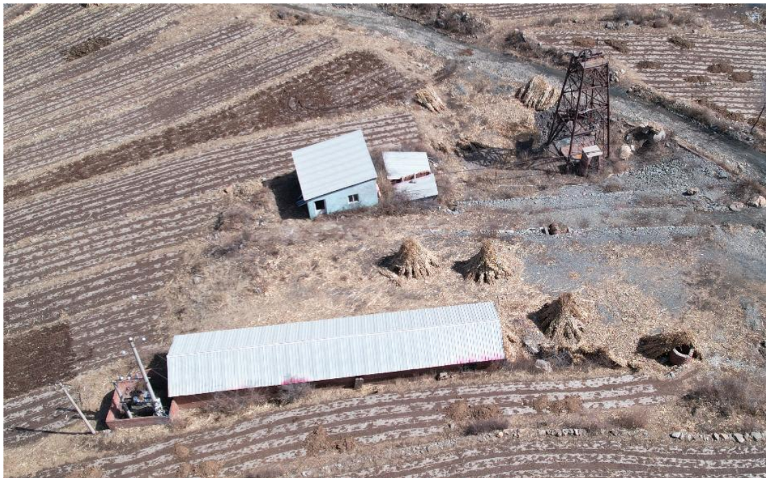
照片 4-1 一号工业场地
