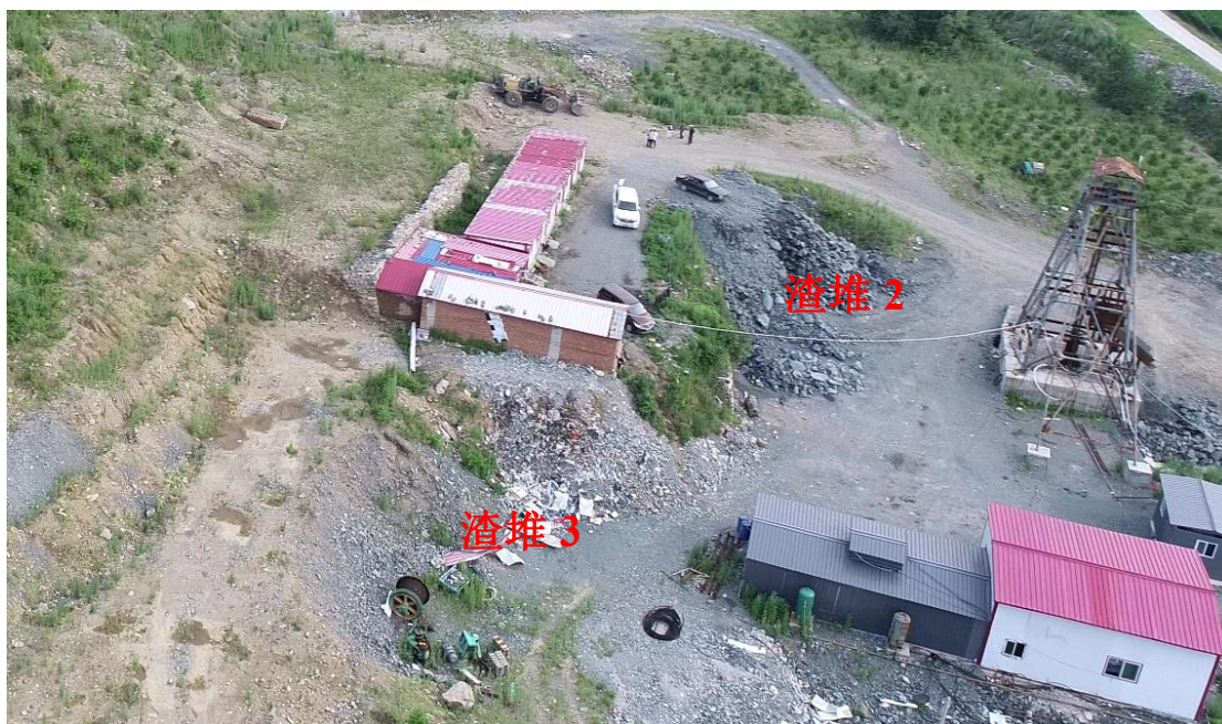
照片2-4 渣堆2、渣堆3治理后照片
