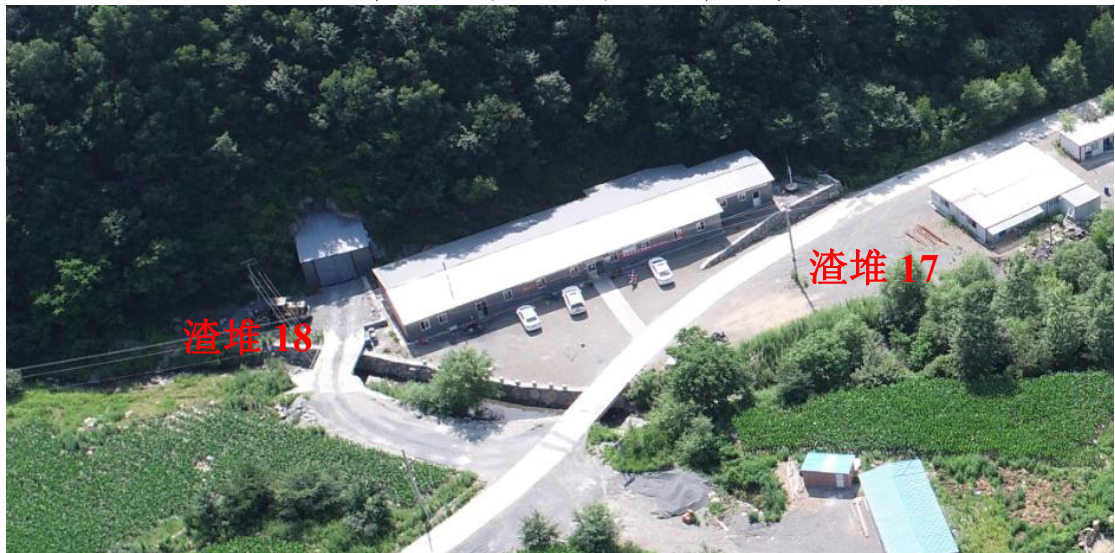
照片2-7 渣堆17、渣堆18治理后照片
