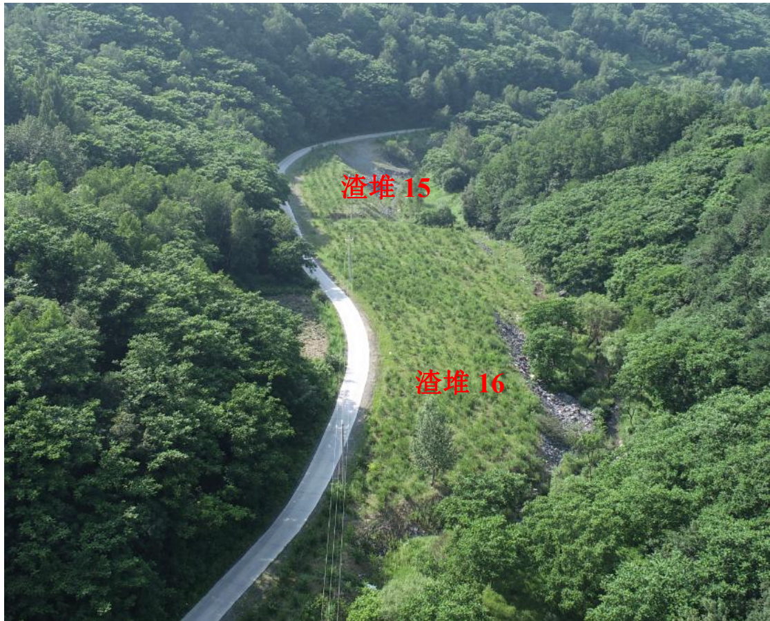
照片2-6 渣堆15、渣堆16治理后照片
