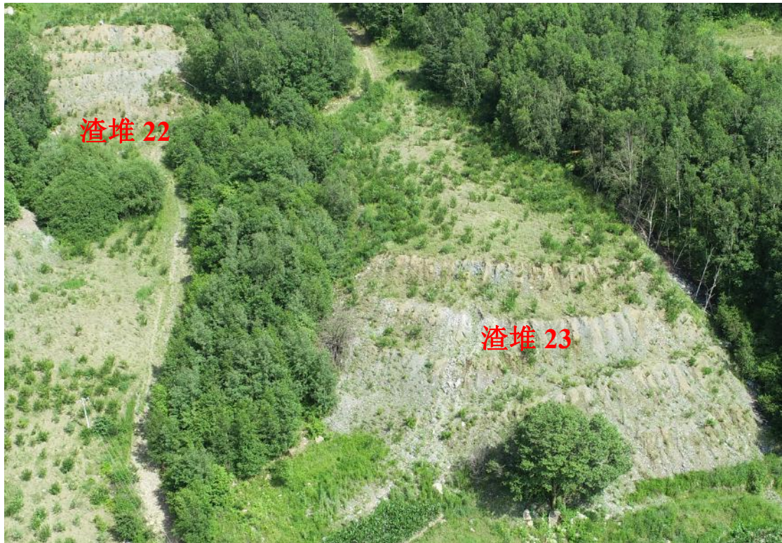
照片2-12 渣堆22、渣堆23治理后照片
