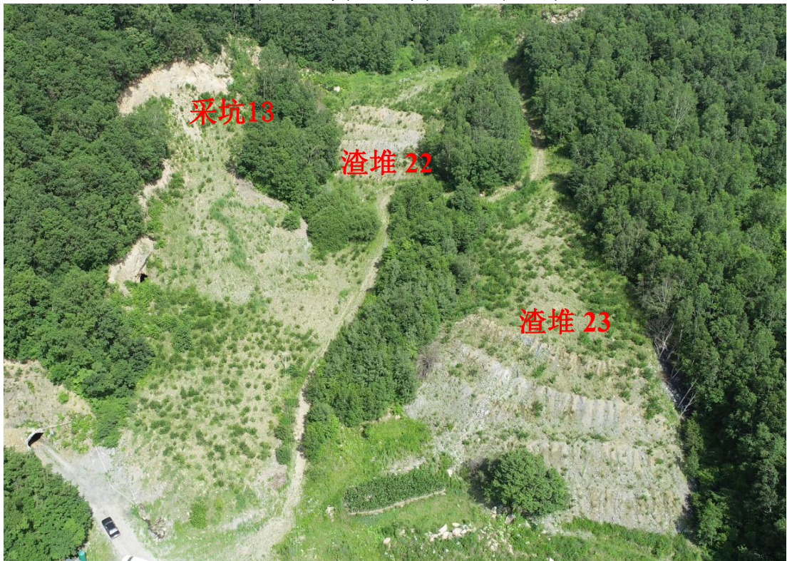
照片2-11 采坑13、渣堆22、渣堆23治理后照片
