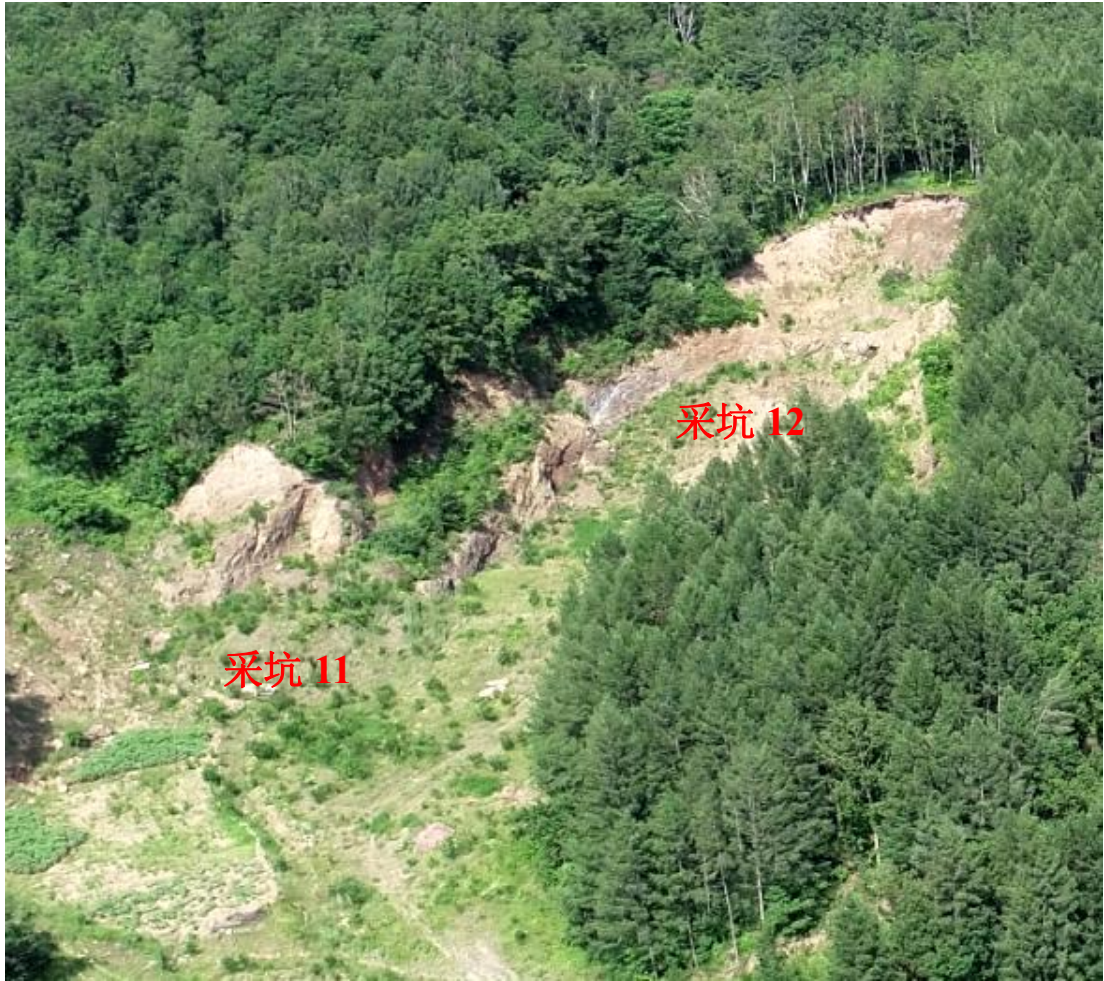
照片2-10 采坑11、采坑12治理后照片
