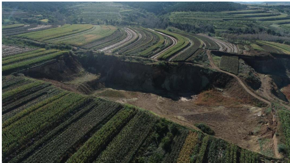
照片 2-2 露天采场东北侧
