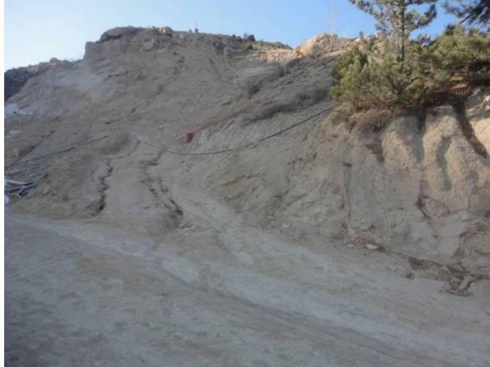
照片 4-3 矿区道路
