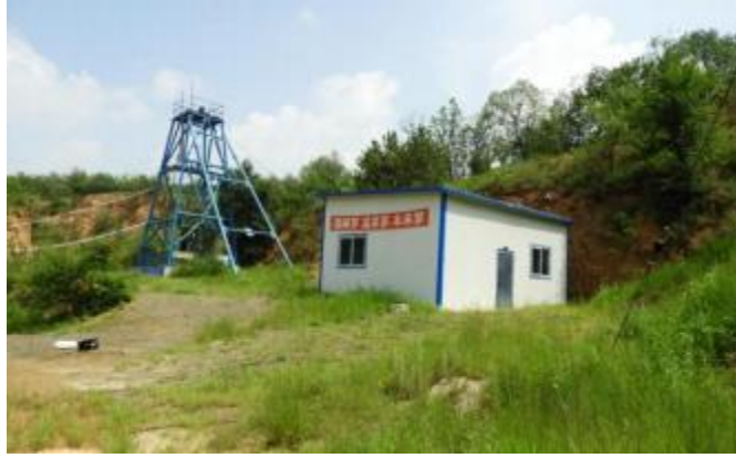
照片 3-3 竖井 (SJ3) 工业场地
