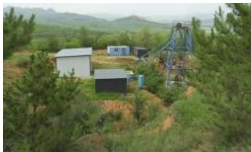
照片 3-4 竖井 (SJ4) 工业场地
