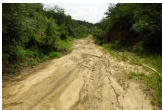
照片 3-32 矿区道路
