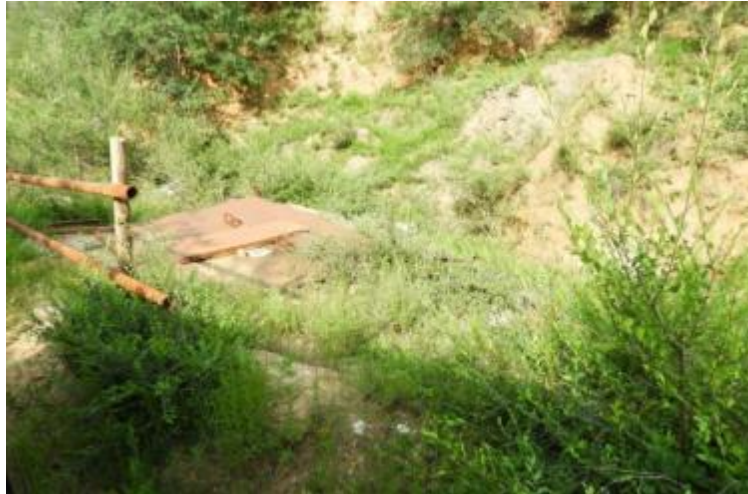
照片 3-1 竖井（SJ1）工业场地
