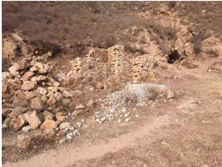
照片 3-5 废弃值班室
