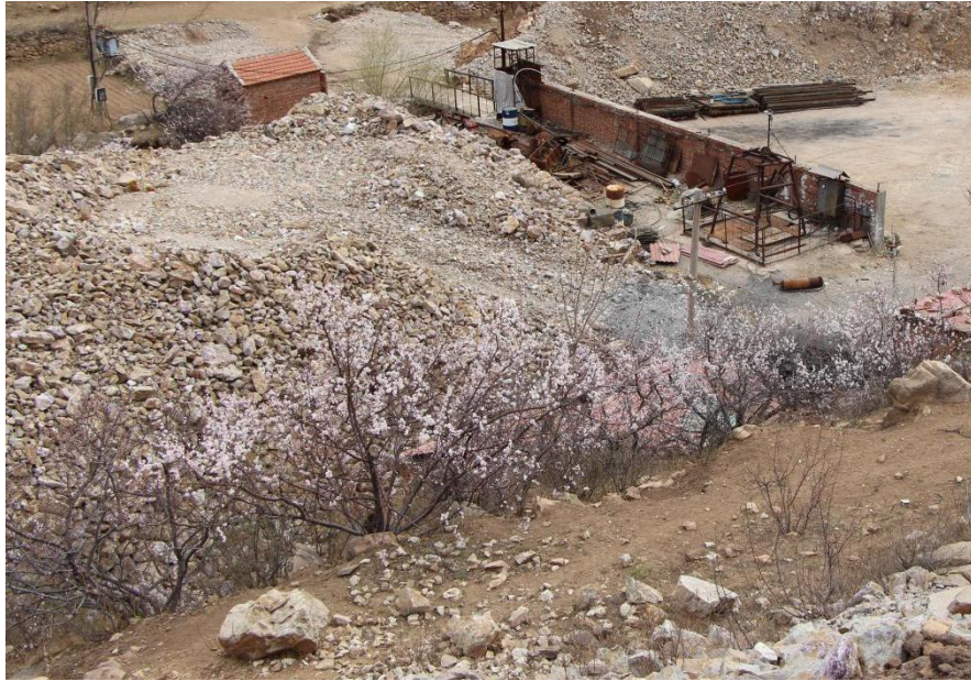
照片 3-4 风井工业场地
