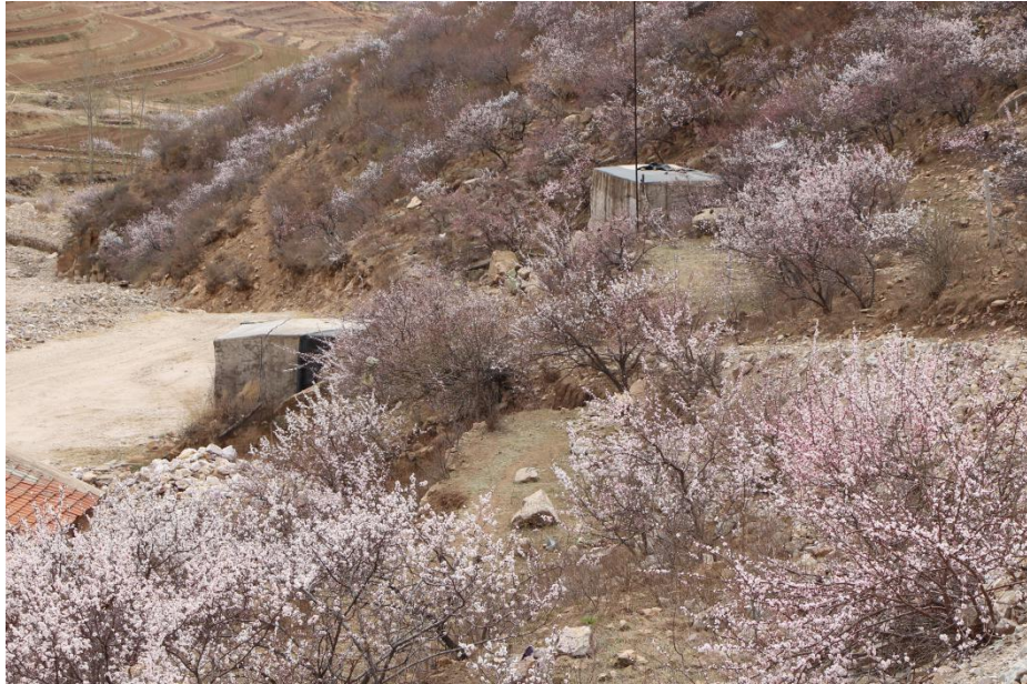
照片 3-6 炸药库、雷管库
