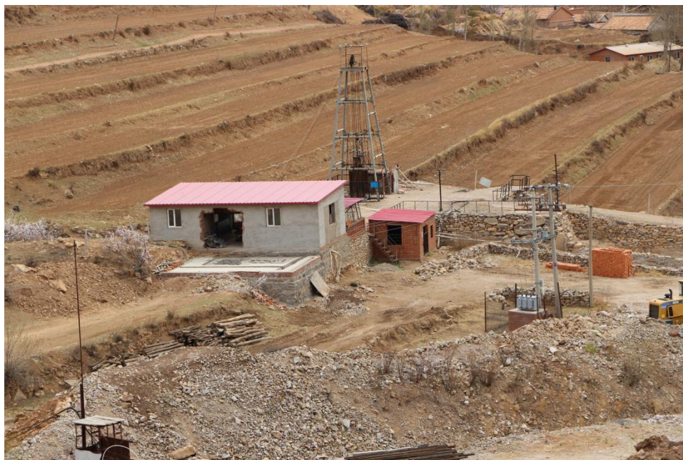
照片 3-2 竖井工业场地
