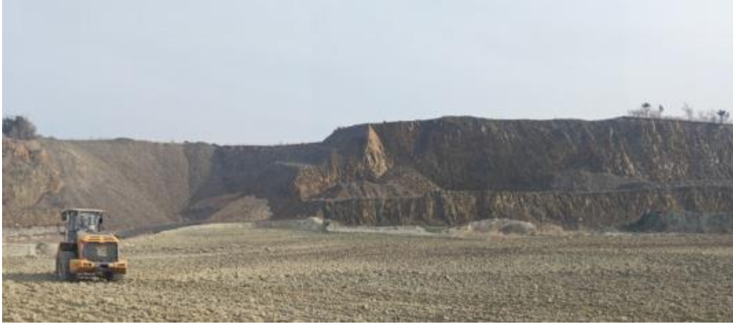
露天采场 1 南部边坡
