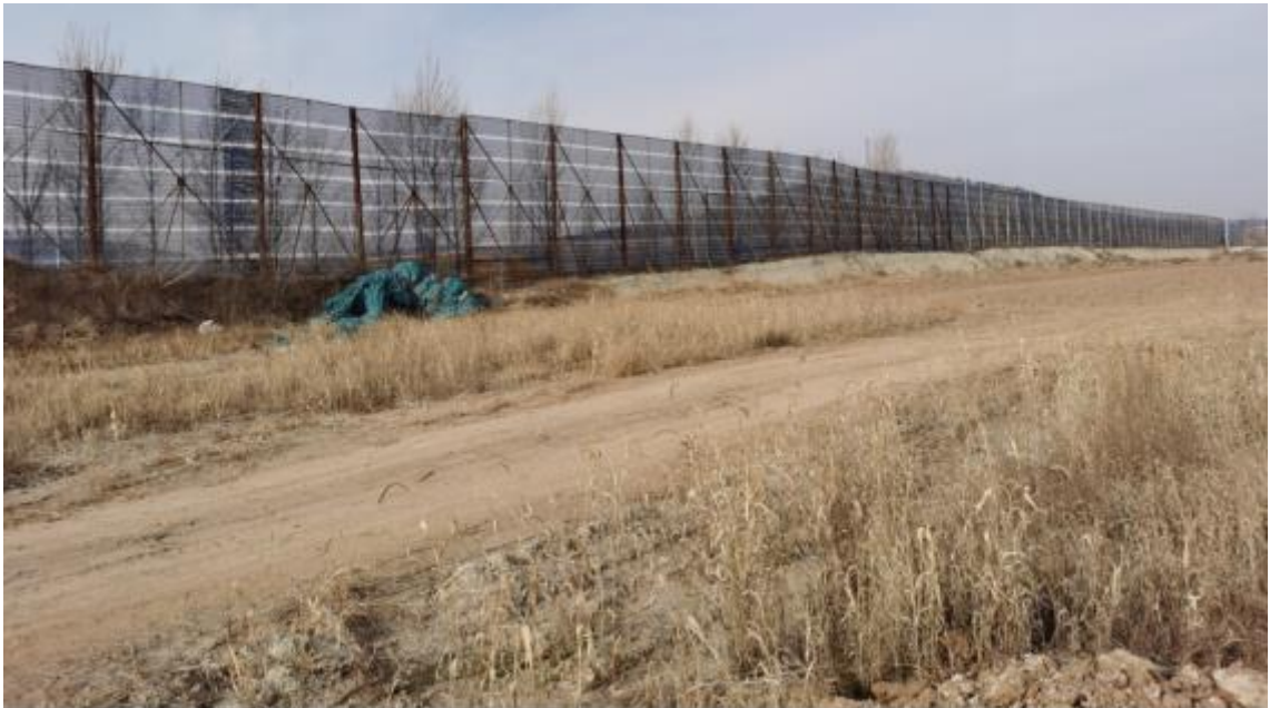
照片 1-7 矿区道路
