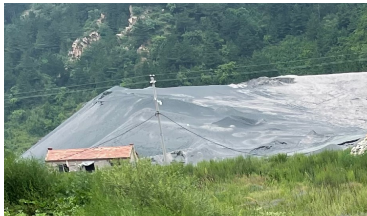
照片 3-7 石料堆放场地 1
