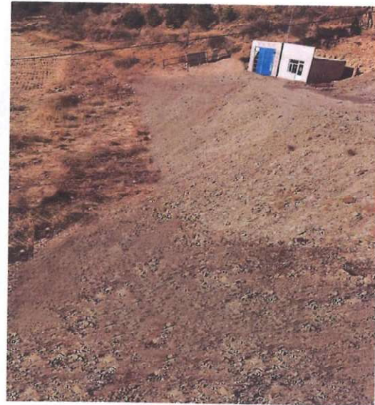
矿石堆放北侧边坡
