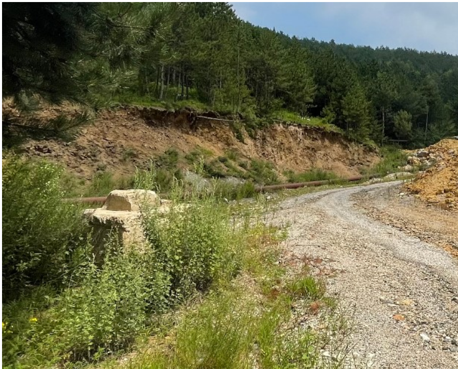
照片 3-18 矿区道路及切坡
