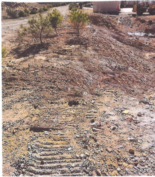
对办公生活区边坡治理
