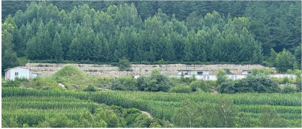
照片 3-10 炸药库及雷管库
