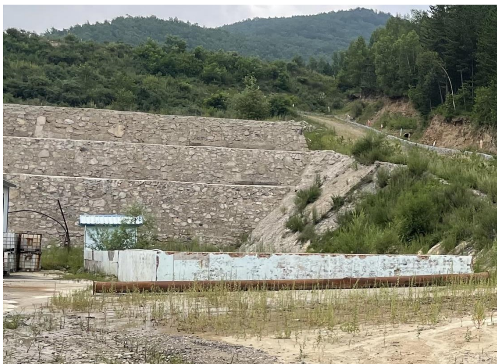
照片 3-17 尾矿库护坡
