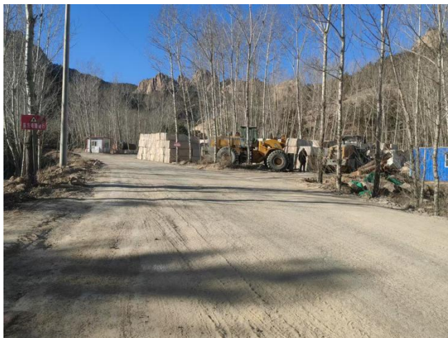
照片3-9 临时堆放场
