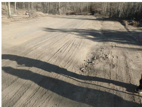
照片 3-7 矿区道路
