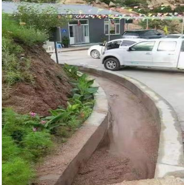
照片4-3 办公生活区排水沟
