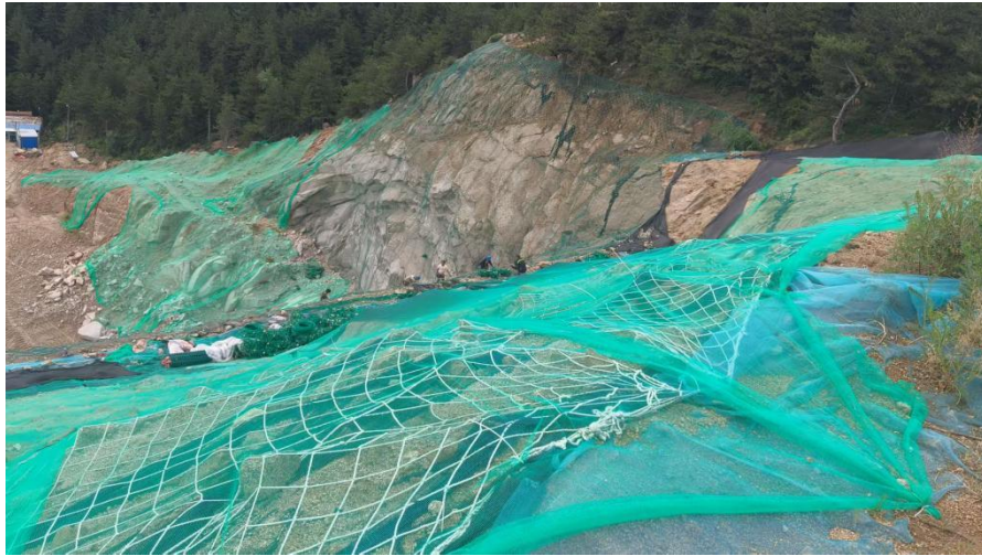
照片4-5 边坡挂网护坡
