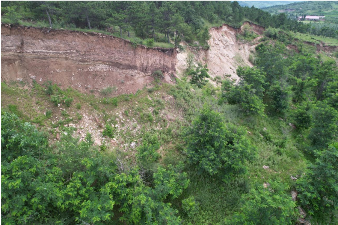
照片4-12 民采坑5（局部切坡）
