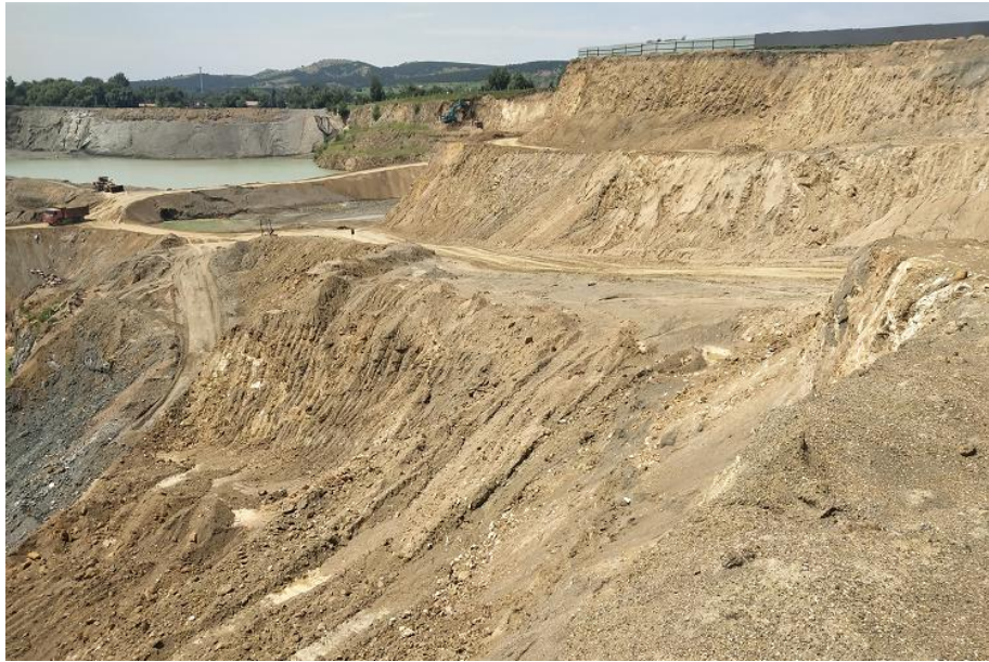
照片1-2 露天采场1边坡
