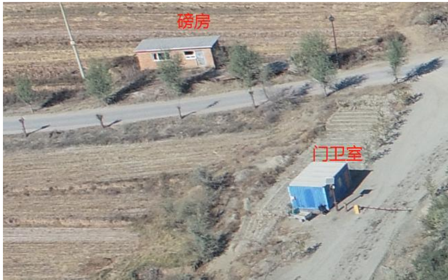
照片 1-16 门卫室及磅房
