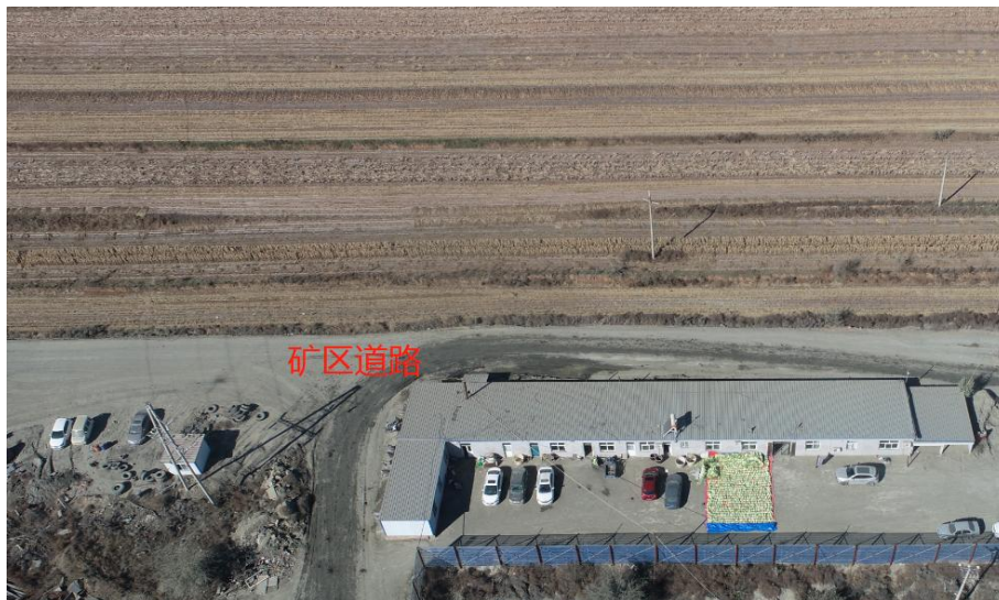
照片 1-18 矿区道路
