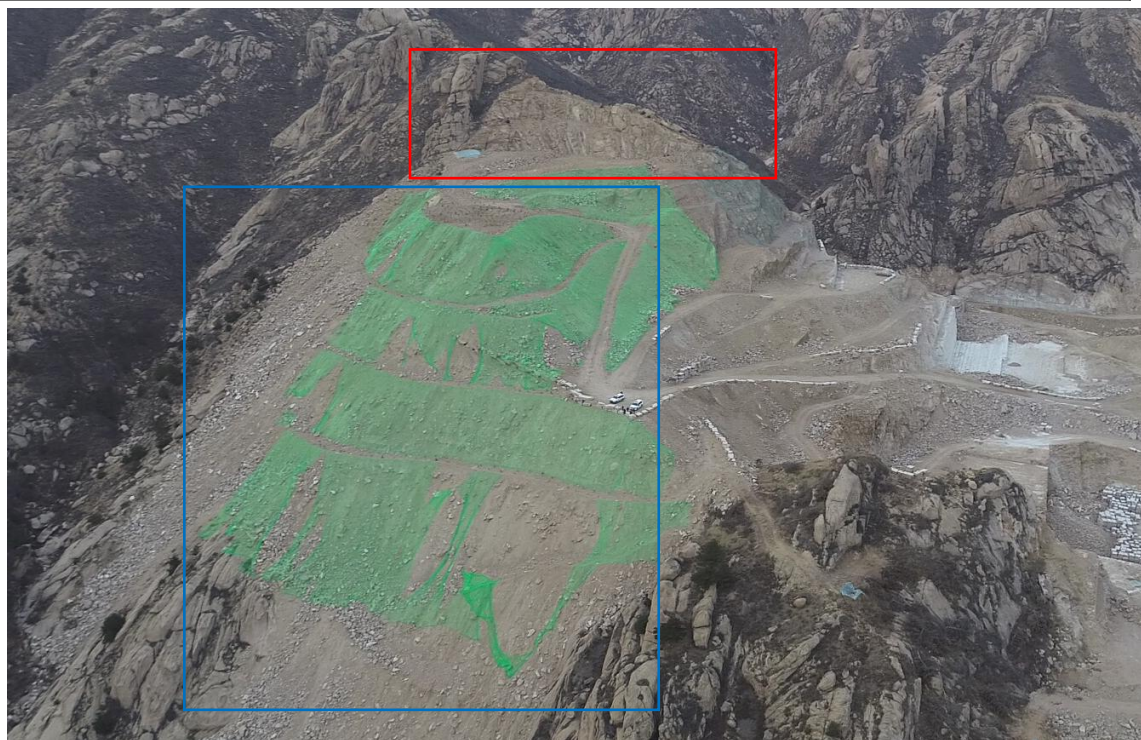
照片4-1 露天采场1垫坡整形效果（红色框）、渣坡整形效果（蓝色框）
