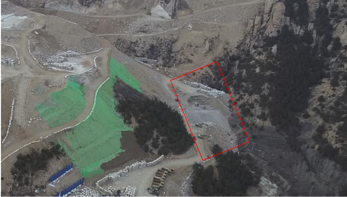
照片 3-7 石料临时堆放场
