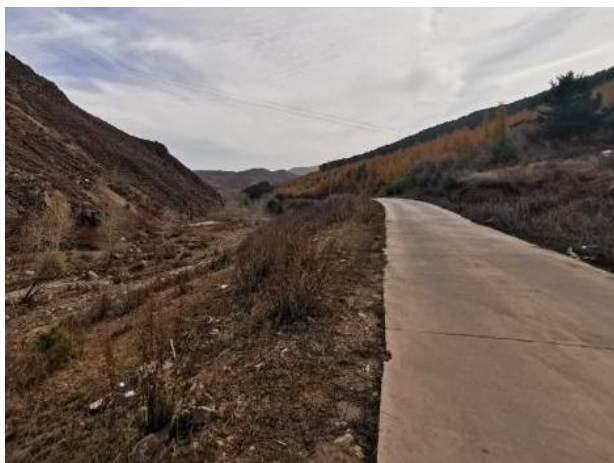
照片3 矿区硬化道路
