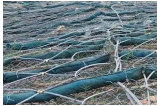
照片 6-2 “生态棒”生态修复效果
