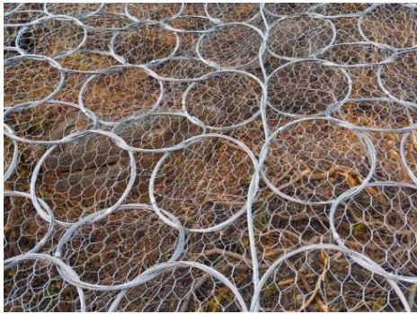
照片 6-1 环形被动防护网挂网治理效果
