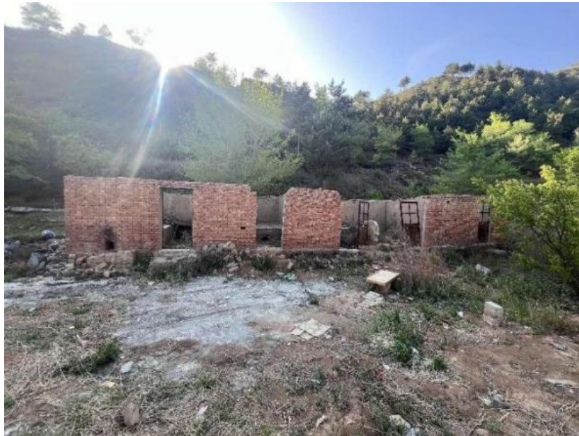
照片 3-6 废弃房屋
