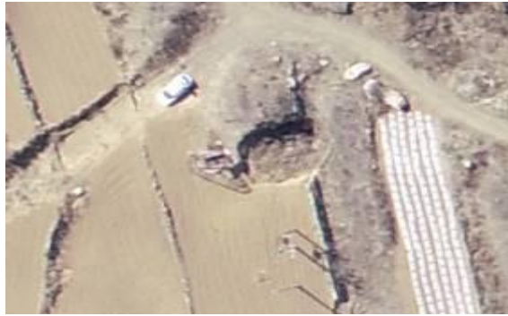
照片 3-39 竖井 2 西侧凹坑
