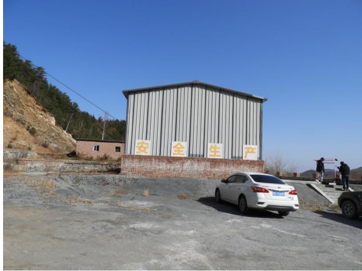
照片 3-2 SJ 工业场地近景照片
