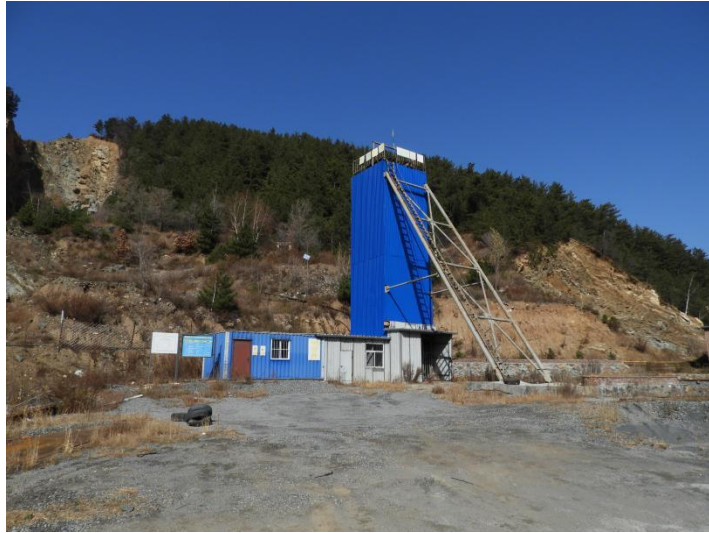
照片3-3 SJ工业场地近景照片
