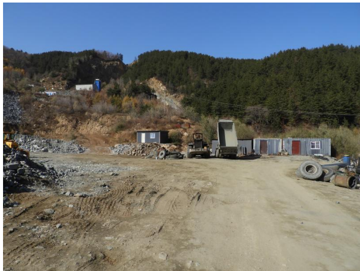
照片3-13 斜坡道工业场地场地照片
