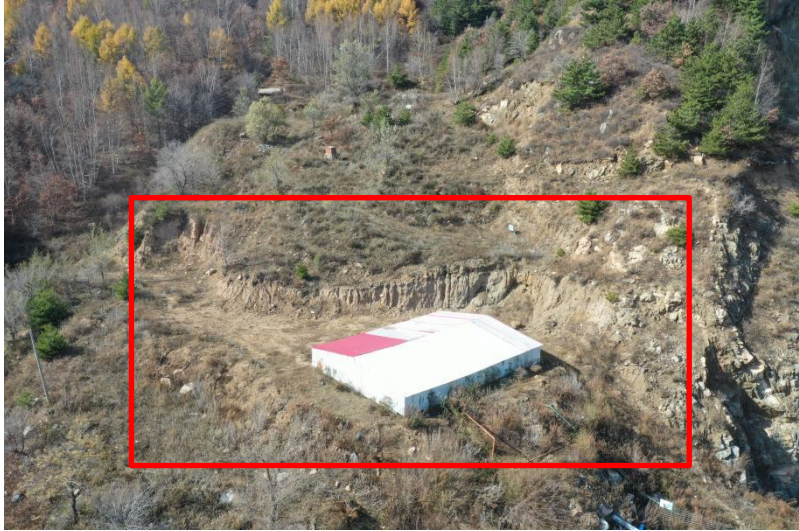
照片 3-34 高位水池场地近景照片
