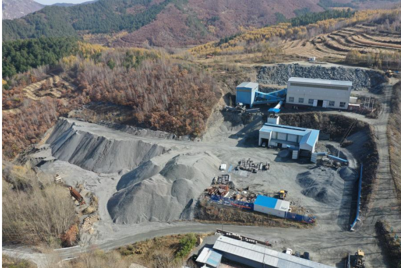
照片3-36 破碎加工场地场地远景照片
