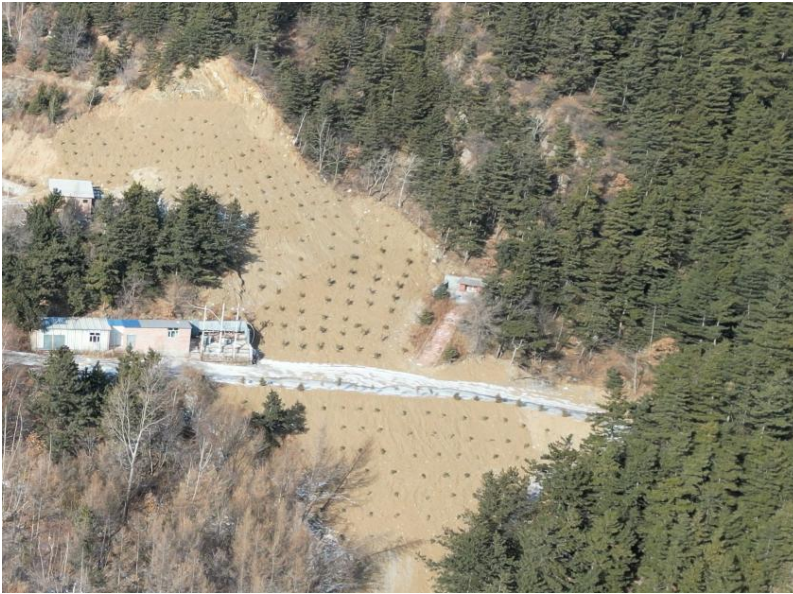
照片 4-6 露天采坑 6、2#废石堆治理效果照片
