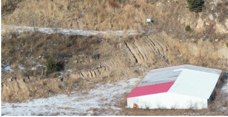
照片 4-5 高位水池（切坡）治理效果照片
