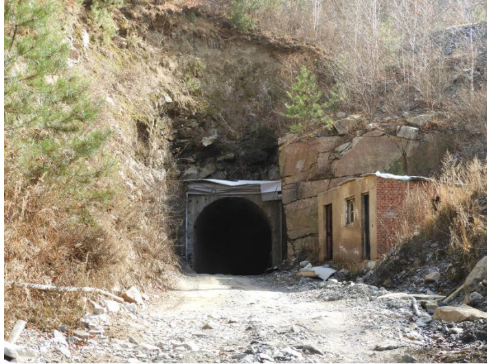
照片 3-12 斜坡道 2 场地照片
