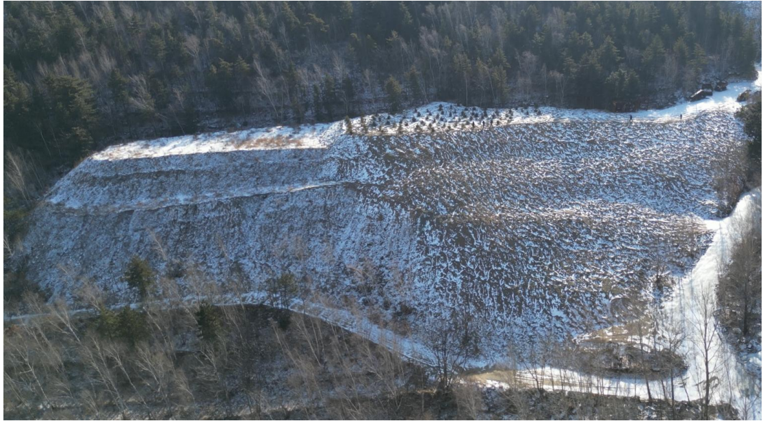
照片 3-23 4#废石堆场地远景照片
