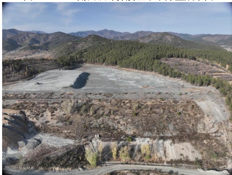
照片3-38 尾矿库场地照片
