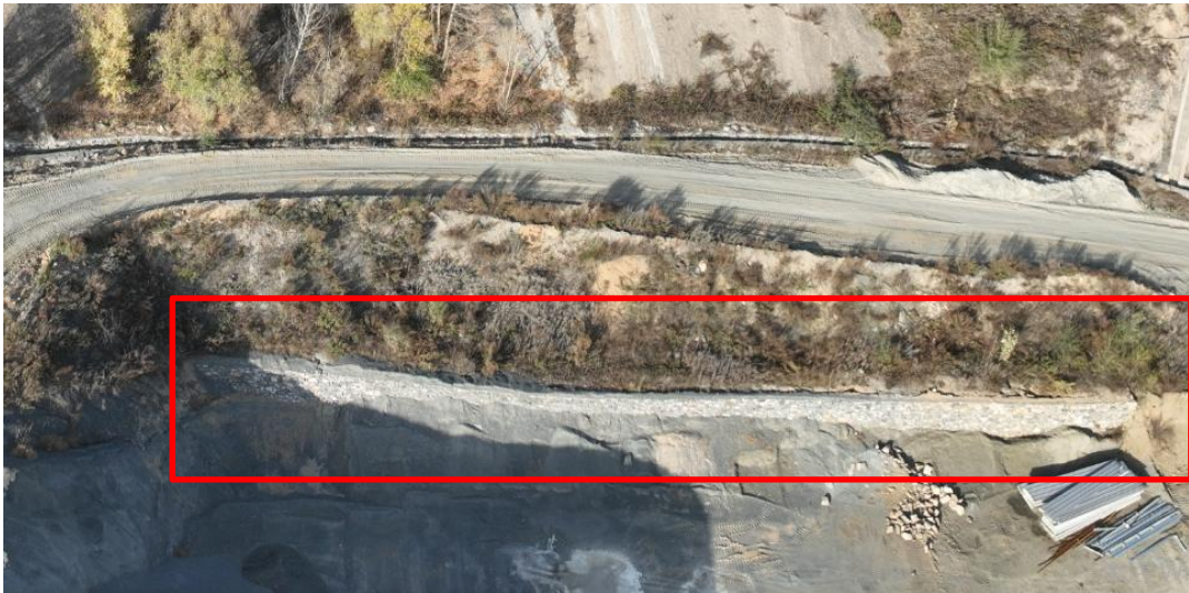
照片 4-2 选矿厂边坡浆砌石挡墙治理效果照片
