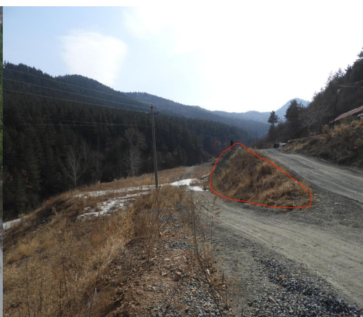
照片3-3 破碎场地南侧堆坡
