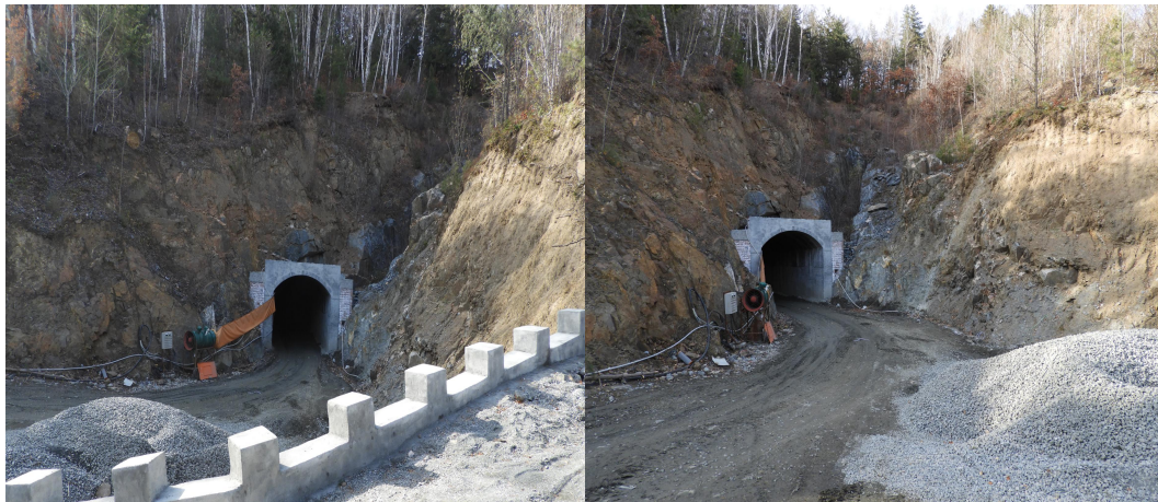
照片 3-1 斜坡道口及切坡
