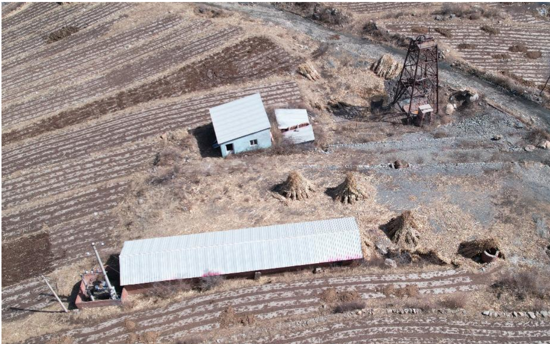
照片 3-1 一号工业场地
