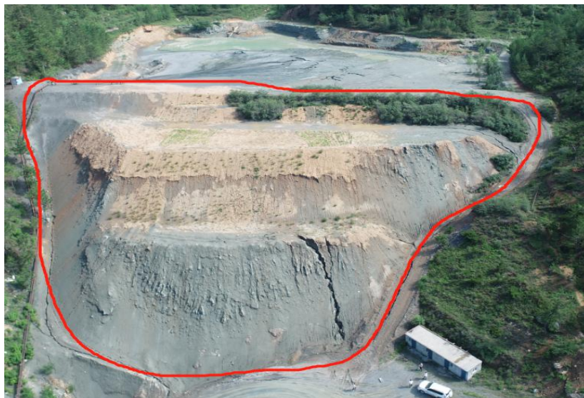
照片4-4 尾矿库坝基坡面治理效果
