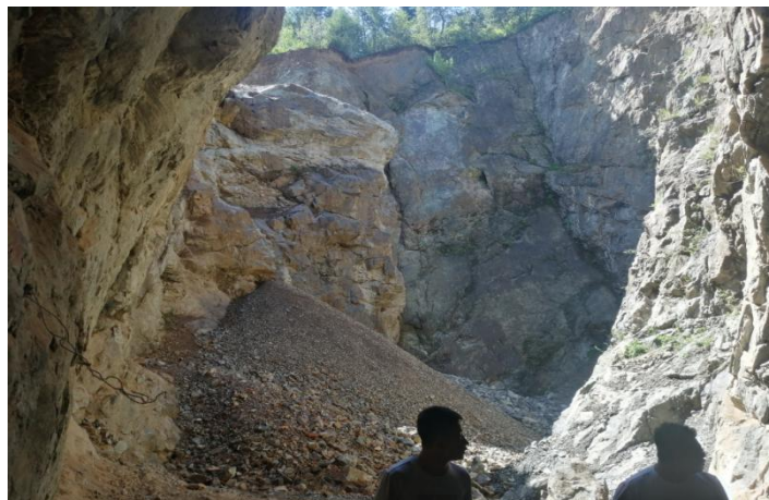
照片4-1 老采坑坑底回填治理效果
