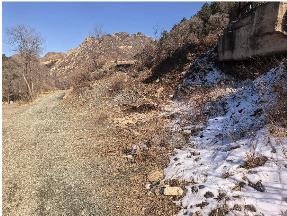
照片4-8 废弃竖井工业场地部分（废石清运）治理效果图
