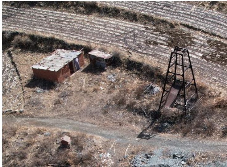
照片3-1 废弃竖井工业场地
