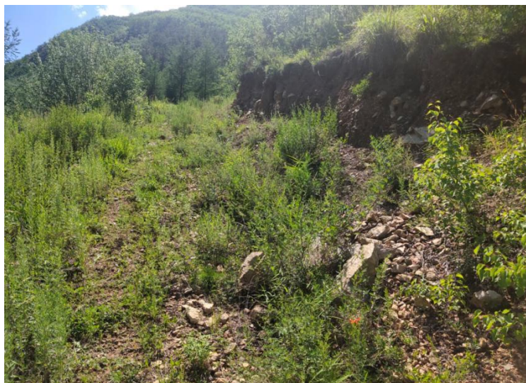
照片 3-15 矿区道路
