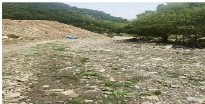
照片 4-15 矿区道路
