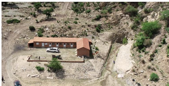
照片 4-5 4 号平硐工业场地
