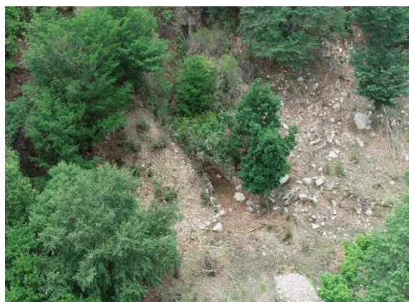
照片 4-1 1号平硐工业场地
