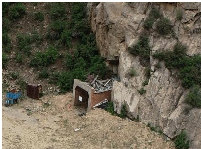
照片 4-4 3号平硐工业场地
