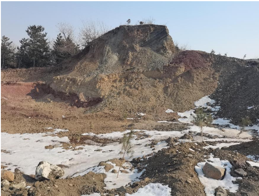
照片 3-5 排土场切坡
