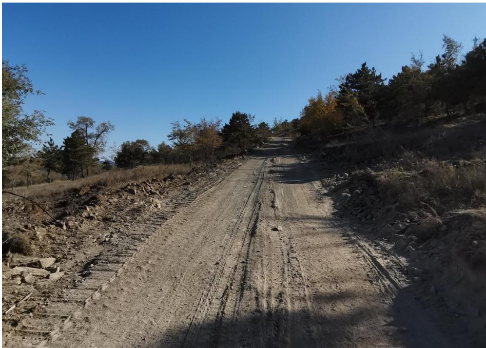
照片 3-12 矿区道路
