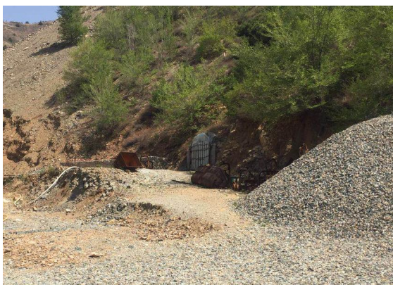
照片 4-3 PD1 平硐洞口及切坡
