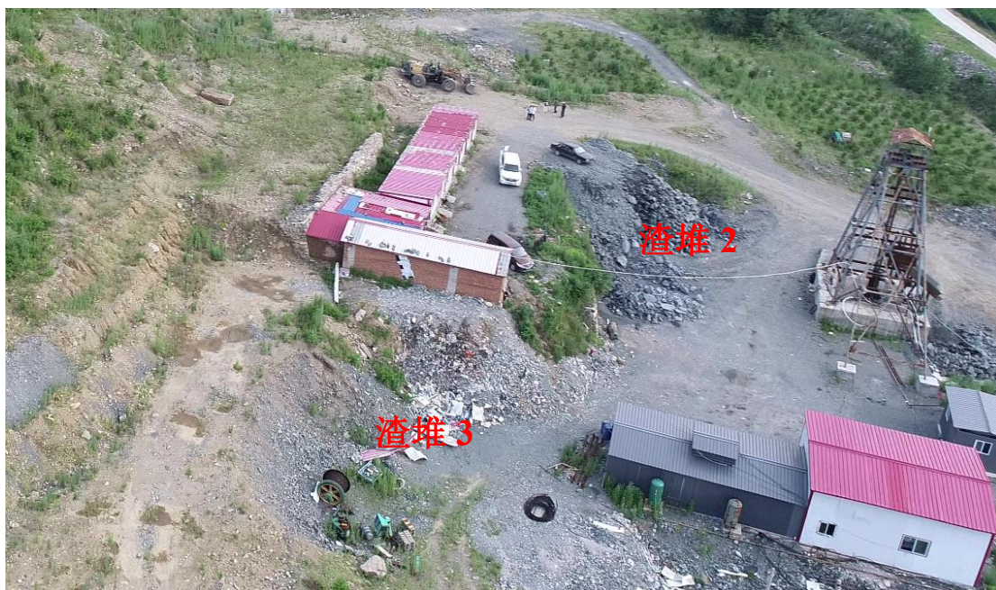
照片 2-4 渣堆 2、渣堆 3 治理后照片
