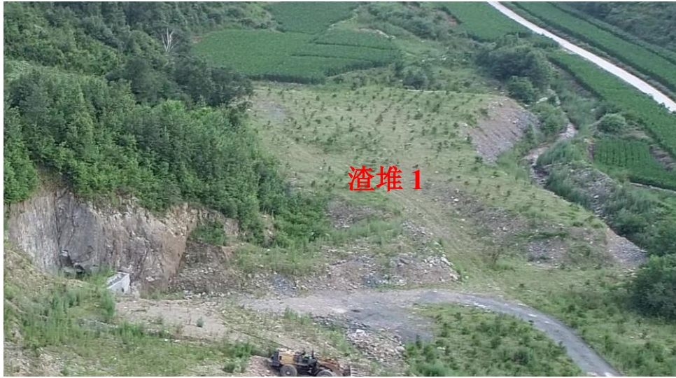
照片 2-2 渣堆 1 治理后照片
