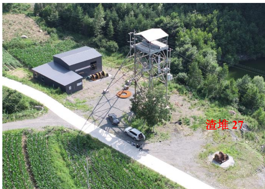
照片 2-13 渣堆 27 治理后照片
