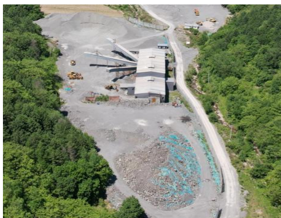
照片 4-33 破碎车间
