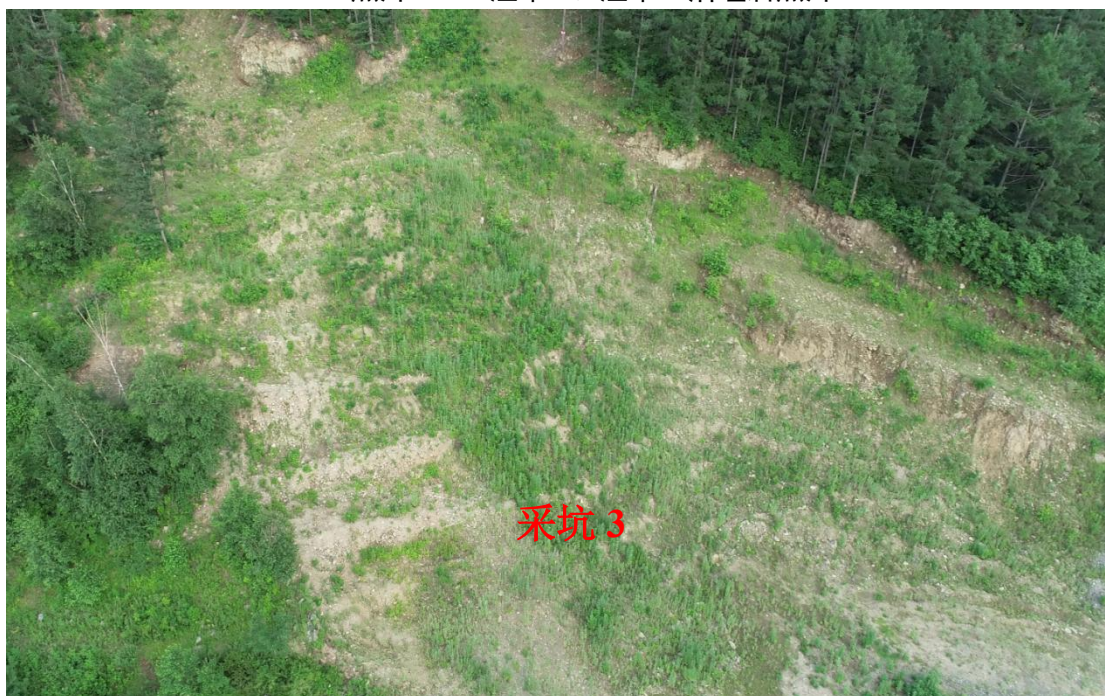
照片 2-5 采坑 3 治理后照片
