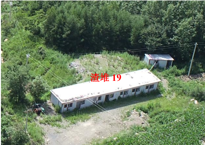
照片 2-8 渣堆 19 治理后照片
