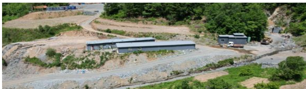
照片 4-2 平硐 2 工业场地
