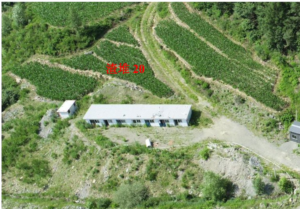
照片 2-9 渣堆 20 治理后照片
