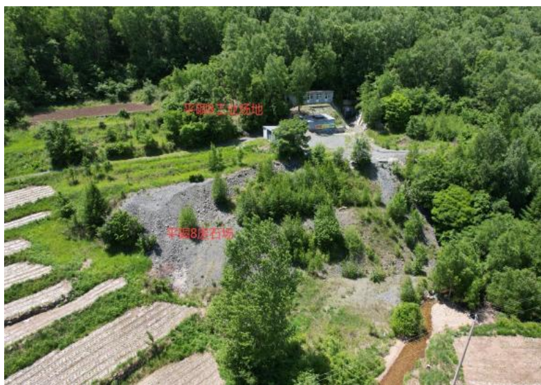
照片 4-8 平硐8 工业场地
