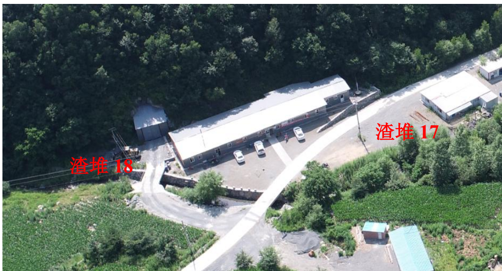
照片 2-7 渣堆 17、渣堆 18 治理后照片
