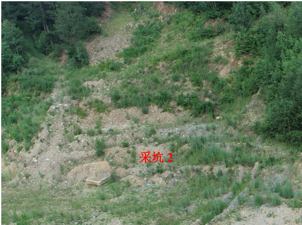
照片 2-3 采坑 2 治理后照片
