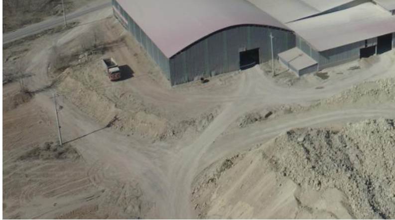
照片 4-4 矿区道路
