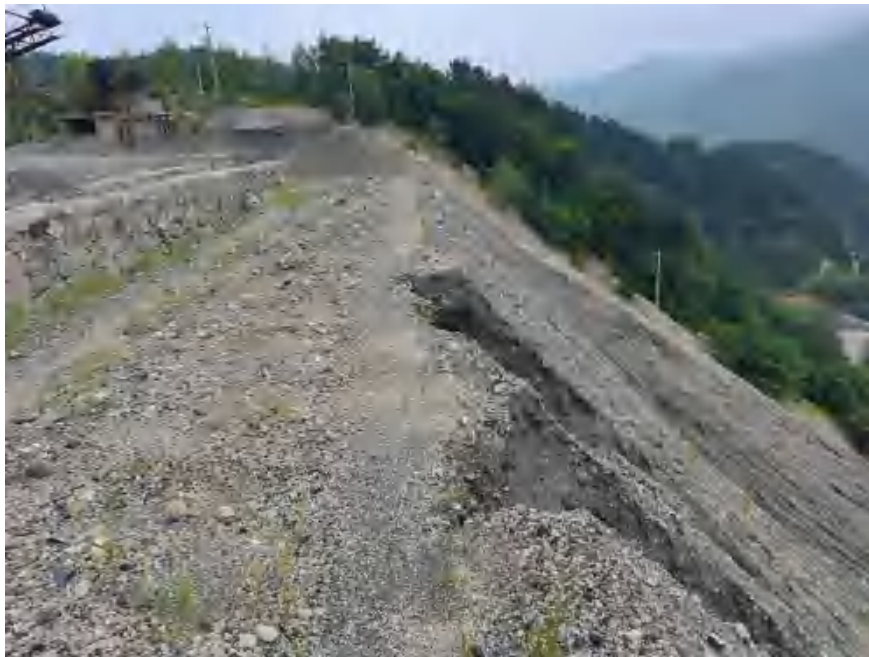
照片3-18 废石场2顶部
