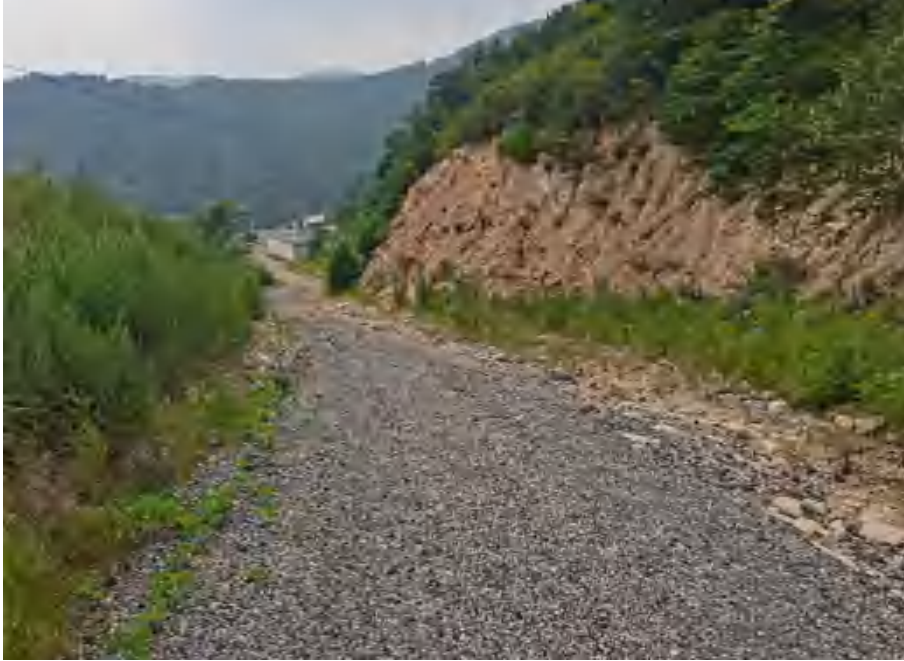
照片 3-25 道路切坡
