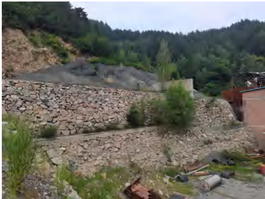
照片3-27 选矿厂内挡墙
