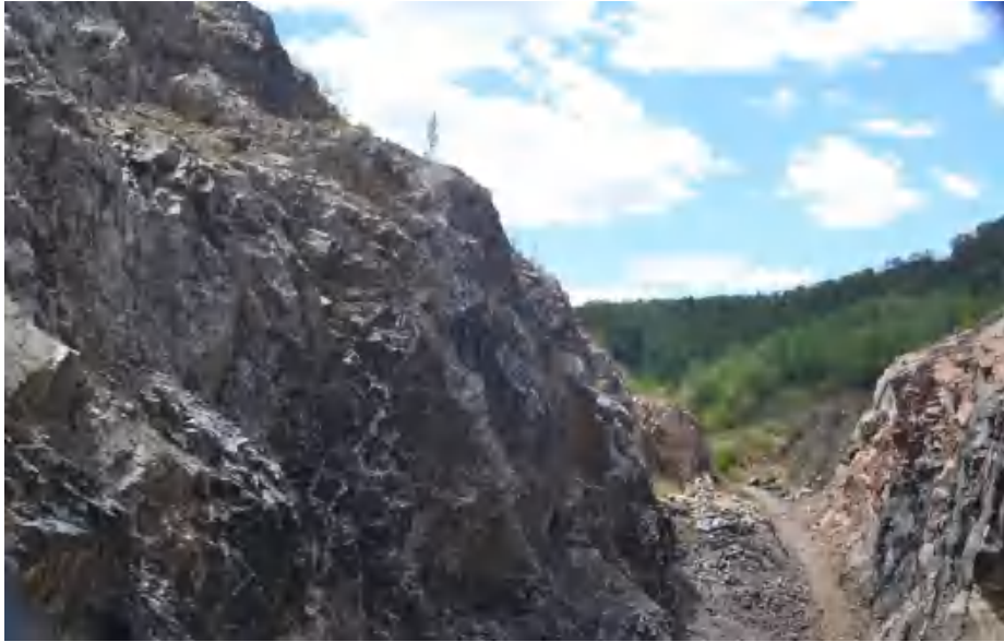
照片4-2 2#废弃露天采坑危岩体清理治理效果
