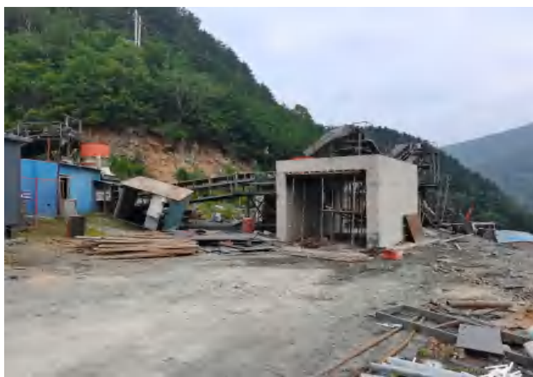
照片 3-5 2#工业场地内设备
