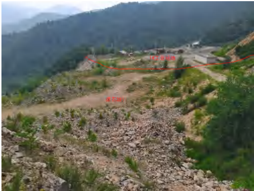
照片3-16 废石场1顶部
