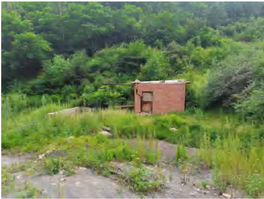
照片 3-29 尾矿库下方集水池及房屋
