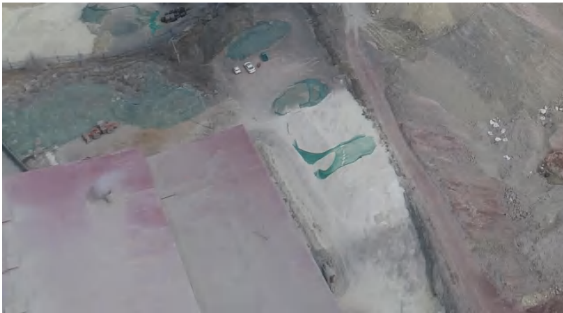
照片 3-21 临时料堆场地（俯视）
