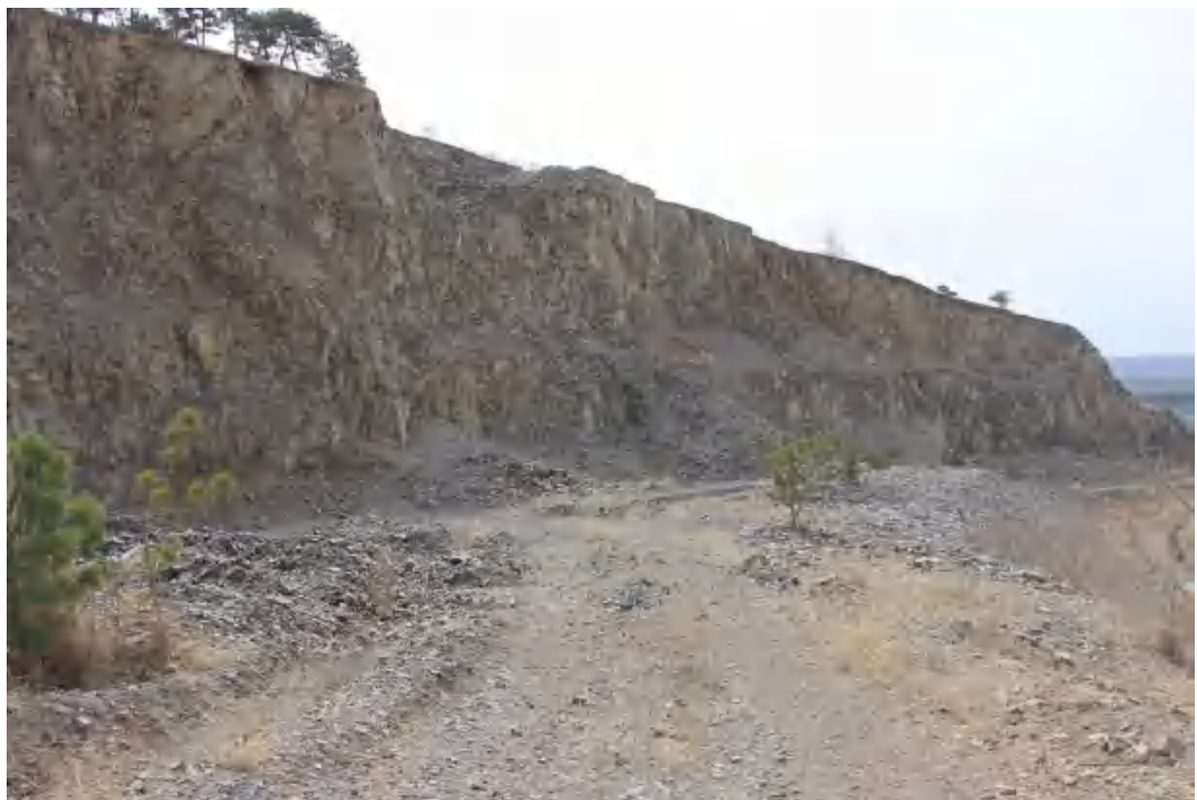
照片3-27 二分期治理区东侧高度边坡
