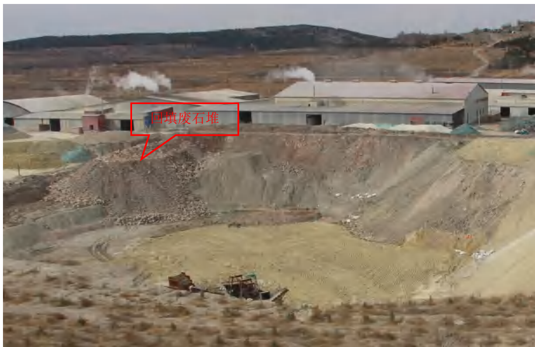
照片3-4 露天采场南侧回填废石堆及边坡
