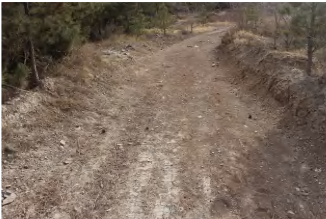
照片3-22 矿区道路（切坡处）
