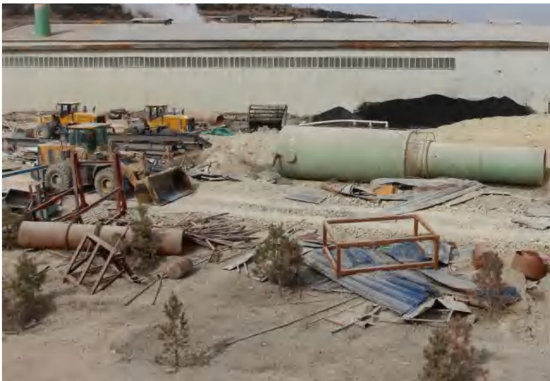
照片 3-15 设备堆放场
