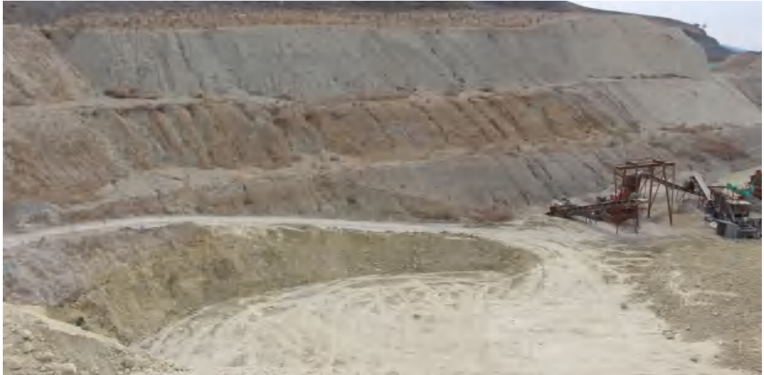
照片3-2 露天采场东侧到界边坡
