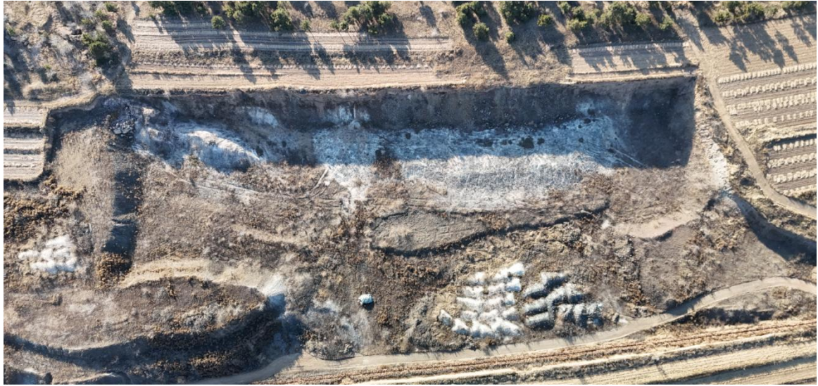
照片 4-8 露天采场 2 近景
