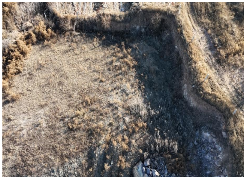
照片 4-25 钻机平台（PT1）切坡
