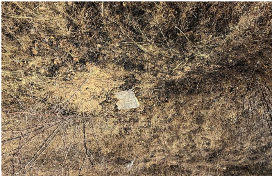
照片 4-30 钻机平台 (PT11) 切坡
