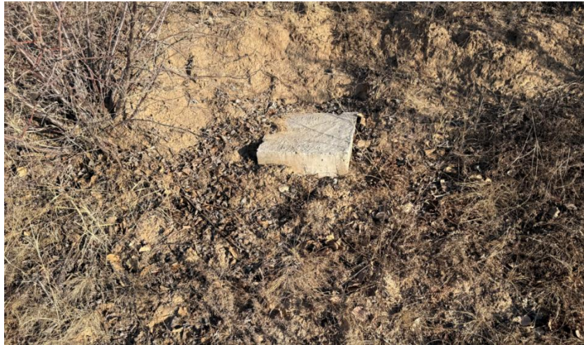
照片 4-29 钻机平台 (PT10) 切坡
