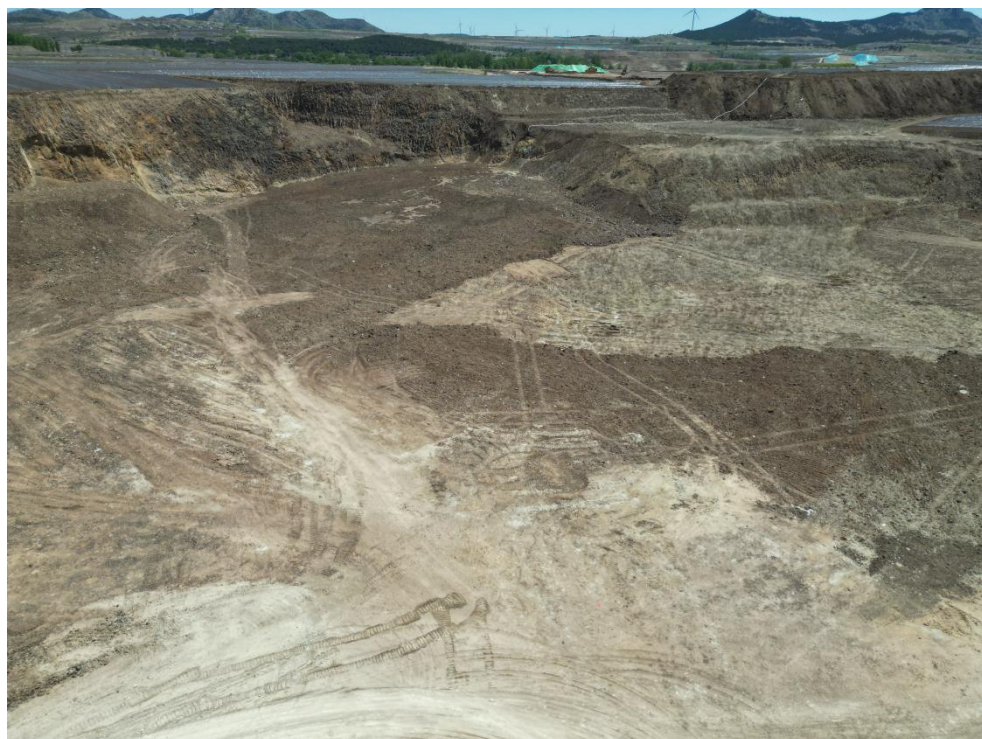
照片 4-5 2#露天采场采掘面
