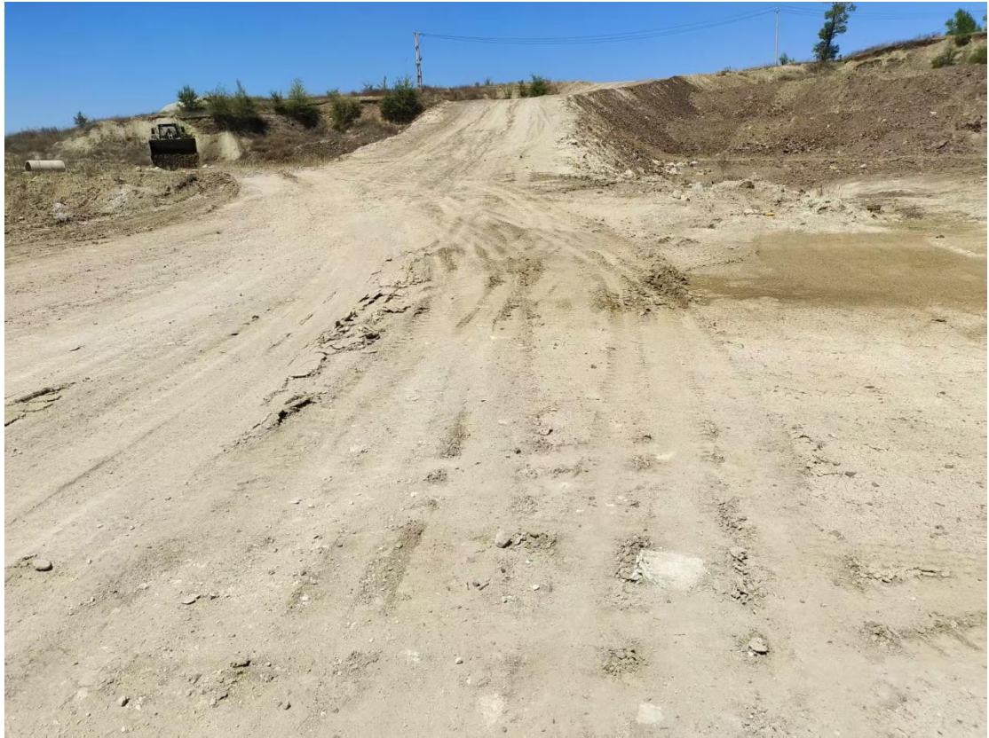
照片 4-7 矿区道路
